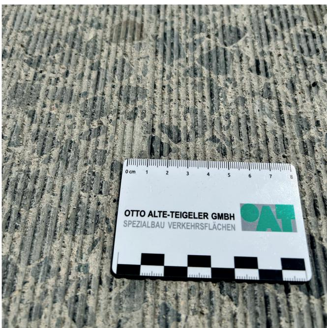
Bild 1 Minimale Überlappung von Grindingbahnen
