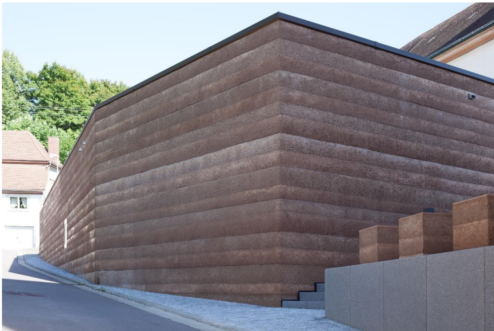
Die Nordseite des Gebäudes.
