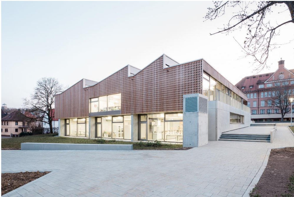
Rechts im Bild die vorgehängte Betonfassade (13 cm) als hinterlüftetes Betonfertigteile vor der 25cm starken Innenwand. Foto: Valentin Schmied
