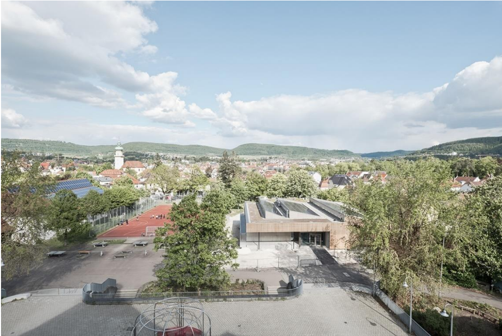
Auf dem Scheddach wurde eine Photovoltaik-Anlage installiert, die den gesamten Primärenergiebedarf des Gebäudes über das Jahr hin abdeckt. Foto: Valentin Schmied
