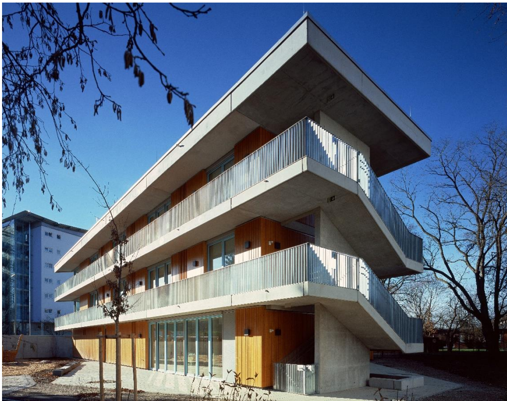
Die Betonfertigteile für die Balkone auf der Ostseite wurden so konstruiert, dass sie möglichst filigran und schlank wirken. © Oliver Betz, Betz Architekten Planungsgesellschaft mbH, München
