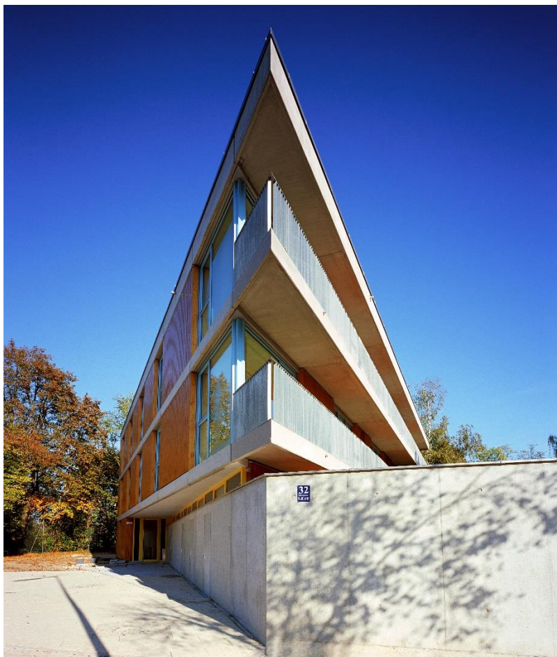
Der Grundstückszuschnitt mit schützenswertem altem Baumbestand und die unveränderbare Lage der Versorgungsleitungen führte zu einem Baukörper in Gestalt einer „Pfeilspitze“ mit drei Geschossen. © Oliver Betz, Betz Architekten Planungsgesellschaft mbH, München
