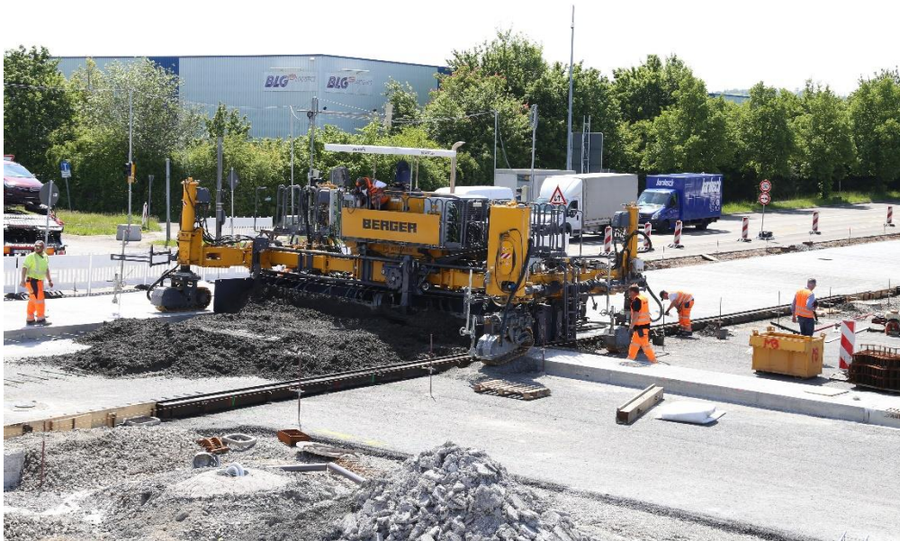
Die neue Kreuzung wurde mit einem Betonfertiger ausgeführt.
