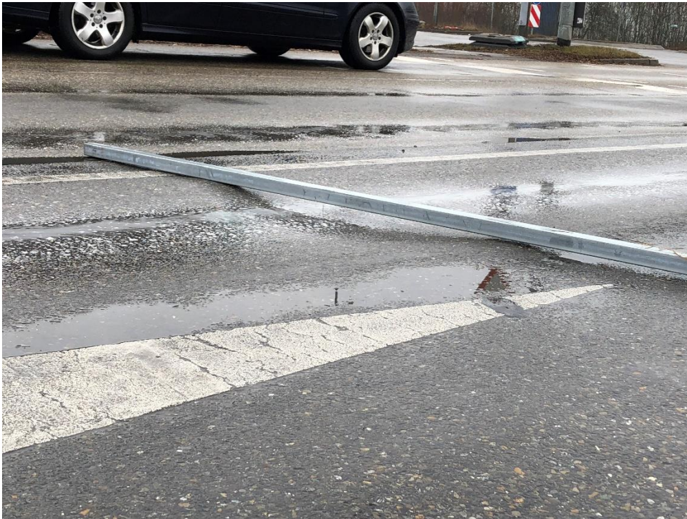
Starke LKW-Belastung erzeugt über die Jahre starke Spurrinnen in der Asphaltbauweise. © BetonBild
