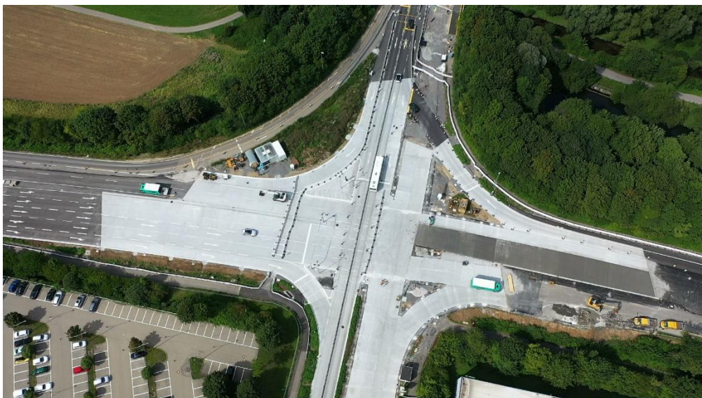
Die Betonfläche im Kreuzungsbereich. © BetonBild
