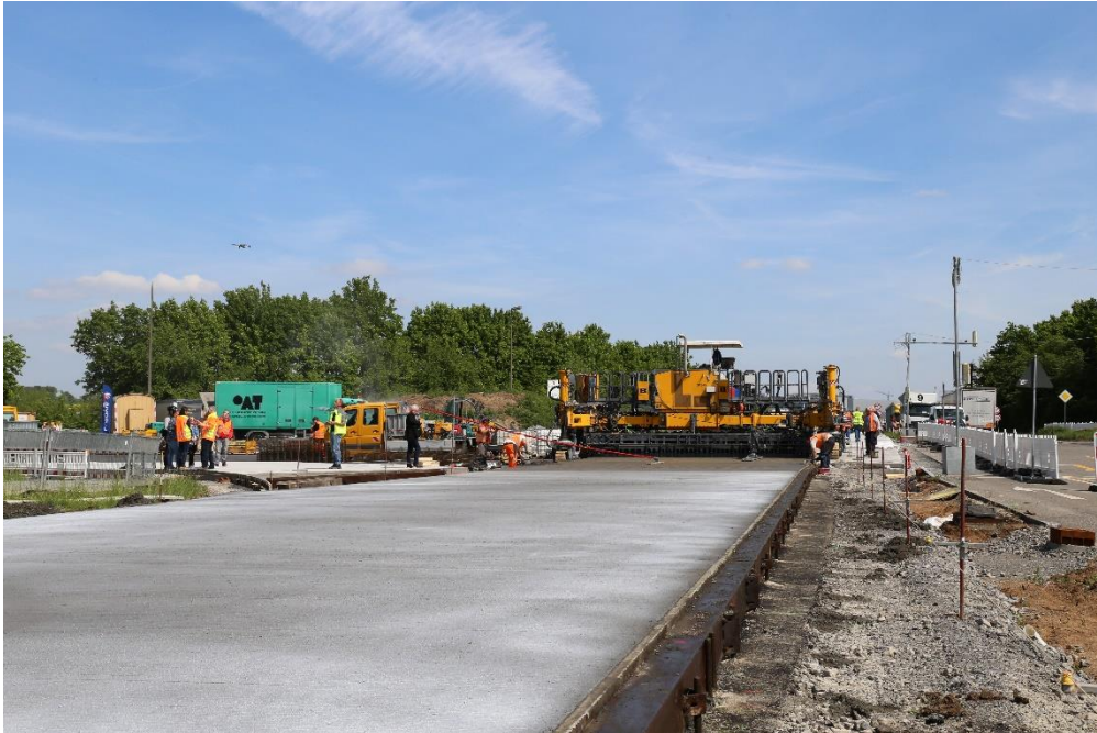
Die Betonfahrbahnplatte ist 26 Zentimeter dick und ist mit sechzig Millimeter langen Polypropylenfasern verstärkt. © BetonBild
