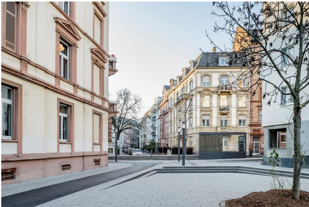
Der rückwärtige Bereich wurde mit einem Betonpflaster mit sandgestrahlter Oberfläche ausgeführt. © Moritz Bernouilly
