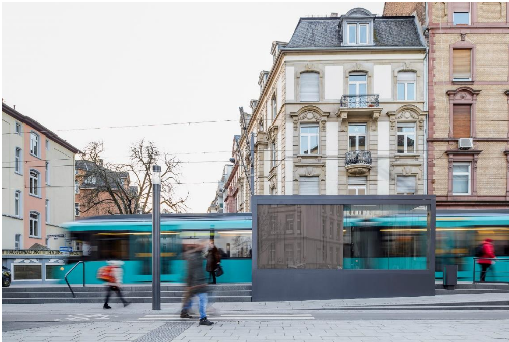
Der Entwurf für die Hochbahnsteige an der Musterschule kombiniert die Funktion des Bahnsteigs mit der des Bürgersteigs. © Moritz Bernouilly
