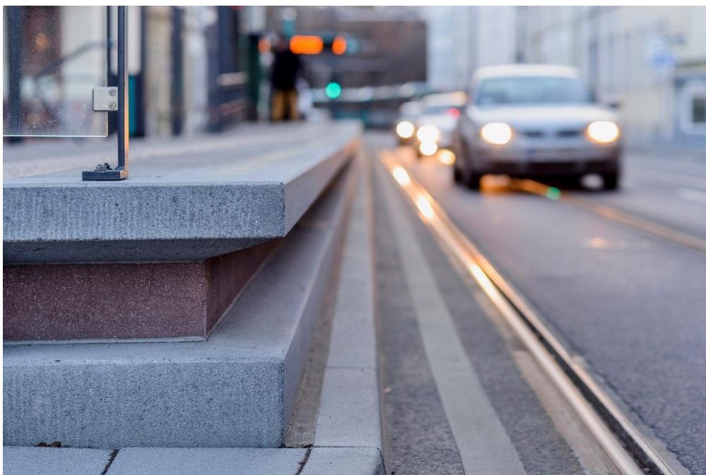
Rot eingefärbter Sichtbeton mit lichtreflektierenden Eigenschaften.
