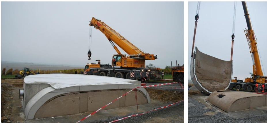
Um die Halbschale später drehen zu können, betonierte man zwei Einbauteile in die Schale mit ein. Foto: hofmann keicher ring architekten
