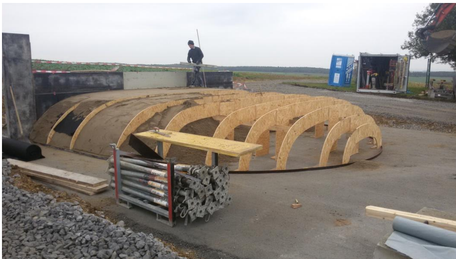
CAD-basiertes Lehrgerüst aus Holzschablonen für die Schalung. Foto: hofmann keicher ring architekten
