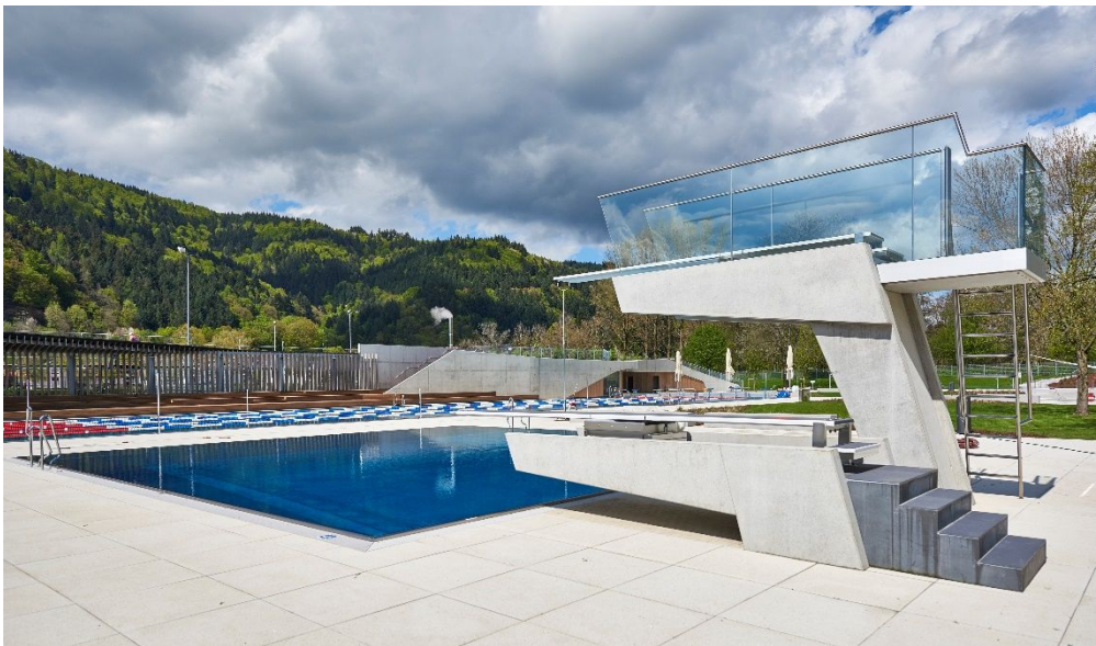
Foto: InformationsZentrumBeton/Stephan Falk
