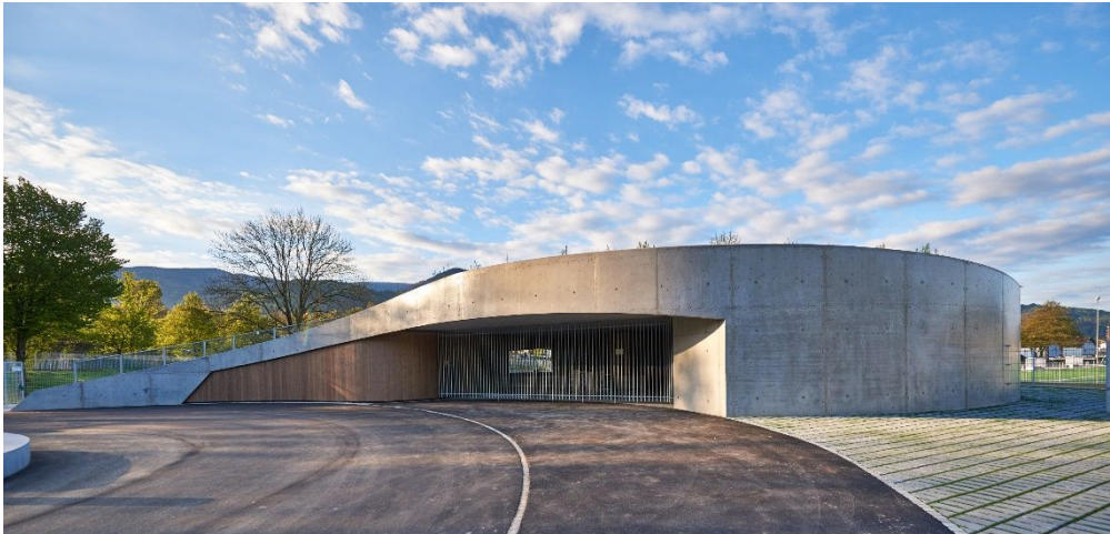
Foto: InformationsZentrumBeton/Stephan Falk
