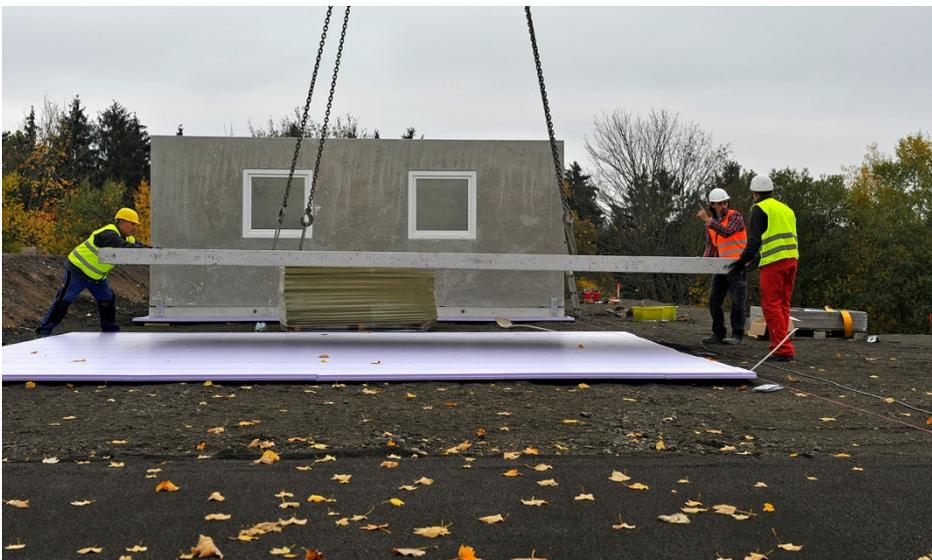
Die Bodenplatte als Fertigteile wird auf die Perimeterdämmung gesetzt.
