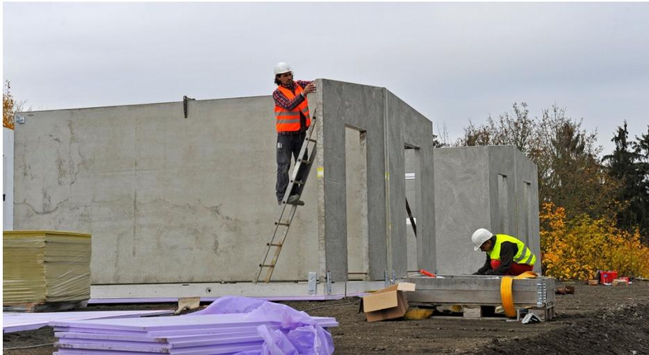
Schnelle Montage – fünf Gebäude werden an einem Tag aufgestellt. Foto: InformationsZentrum Beton/Meta Welling
