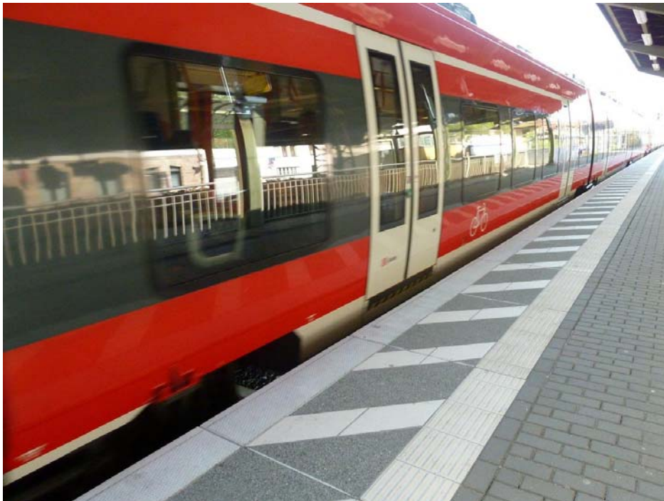
Nach der Sanierung: Durch den Einsatz von modula flex als Ergänzungsplatte konnte der Abstand der konventionellen Bahnsteigkante zur neuen Gleisgradienten angepasst werden. Foto: Hering Bau
