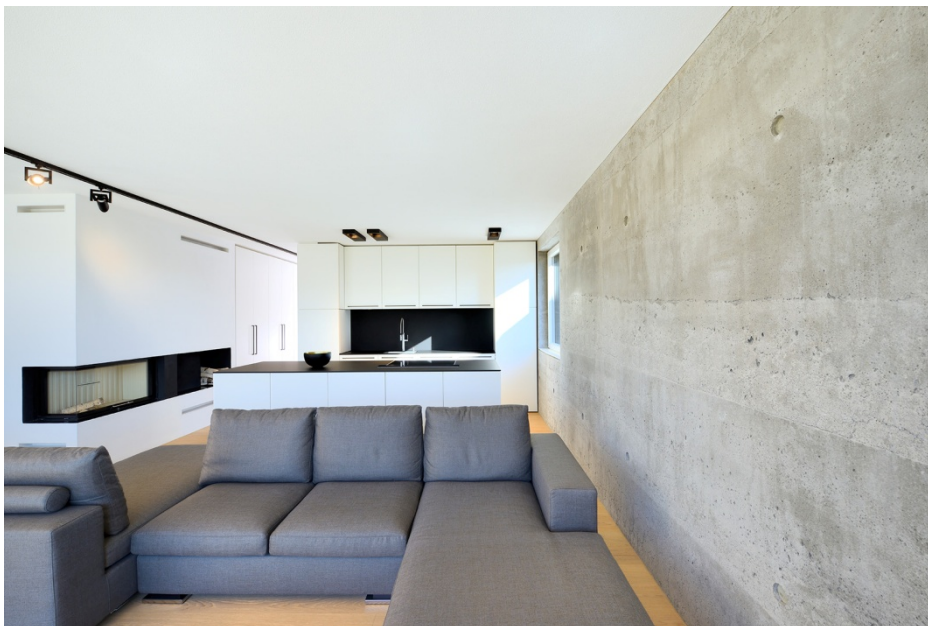
Die 50 cm starken Außenwände des Gebäudes bestehen aus Infralichtbeton mit einer Rohdichte von nur 700kg/m 3 . Foto: InformationsZentrum Beton/Peters
