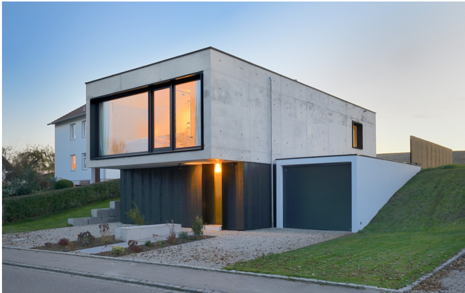
Die 50 cm starken Außenwände des Gebäudes bestehen aus Infralichtbeton. Foto: InformationsZentrum Beton/Peters
