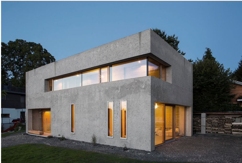
Die 45 cm starken Außenwände des Gebäudes bestehen aus Leichtbeton Foto: InformationsZentrum Beton/ Darko Todorovic
