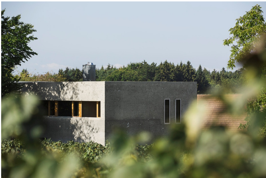
Für die Außenseiten entschieden sich die Bauherren für Handstocken und Hydrophobieren. Foto: InformationsZentrum Beton/Darko Todorovic
