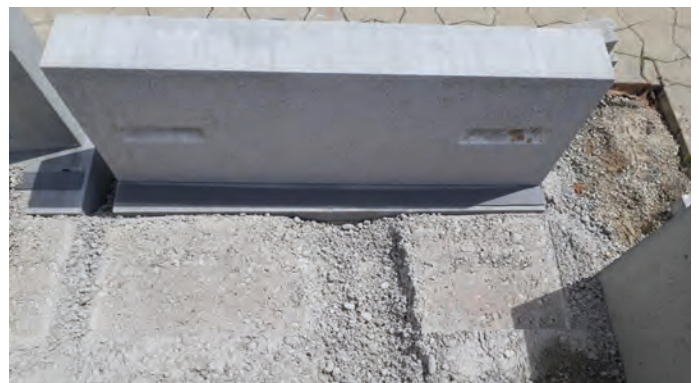
Herkömmliche Blockstufe mit Schubnut
