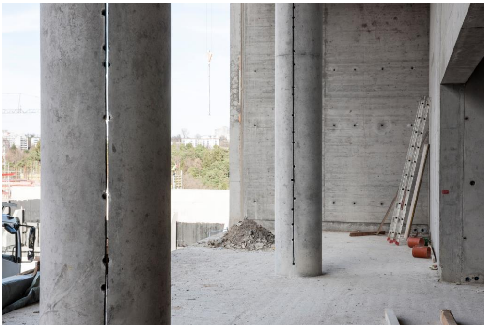
Sichtbeton gebohrt und geschlitzt: Verschiedene Sichtbetonflächen stehen im GUZ nach Fertigstellung in Bezug zu den hohen Säulen. Foto: Frank Kleinbach, Stuttgart
