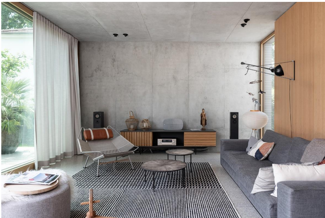
Der Sichtbetonbau erforderte einen präzisen Detaillierungsplan für Ausschnitte und flächenbündige Anschlüsse. © Bonauer Bölling Partnerschaft von Architekten mbB
