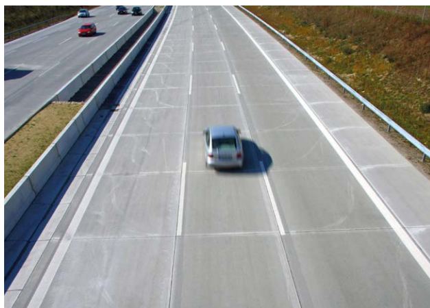
Bild 1: Betonfahrbahndecke im Fernstraßenbau
