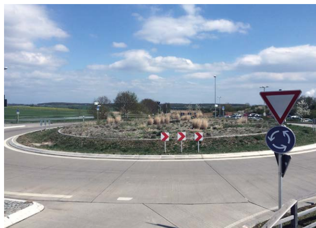
Bild 2: Betonfahrbahndecke im kommunalen Straßenbau
