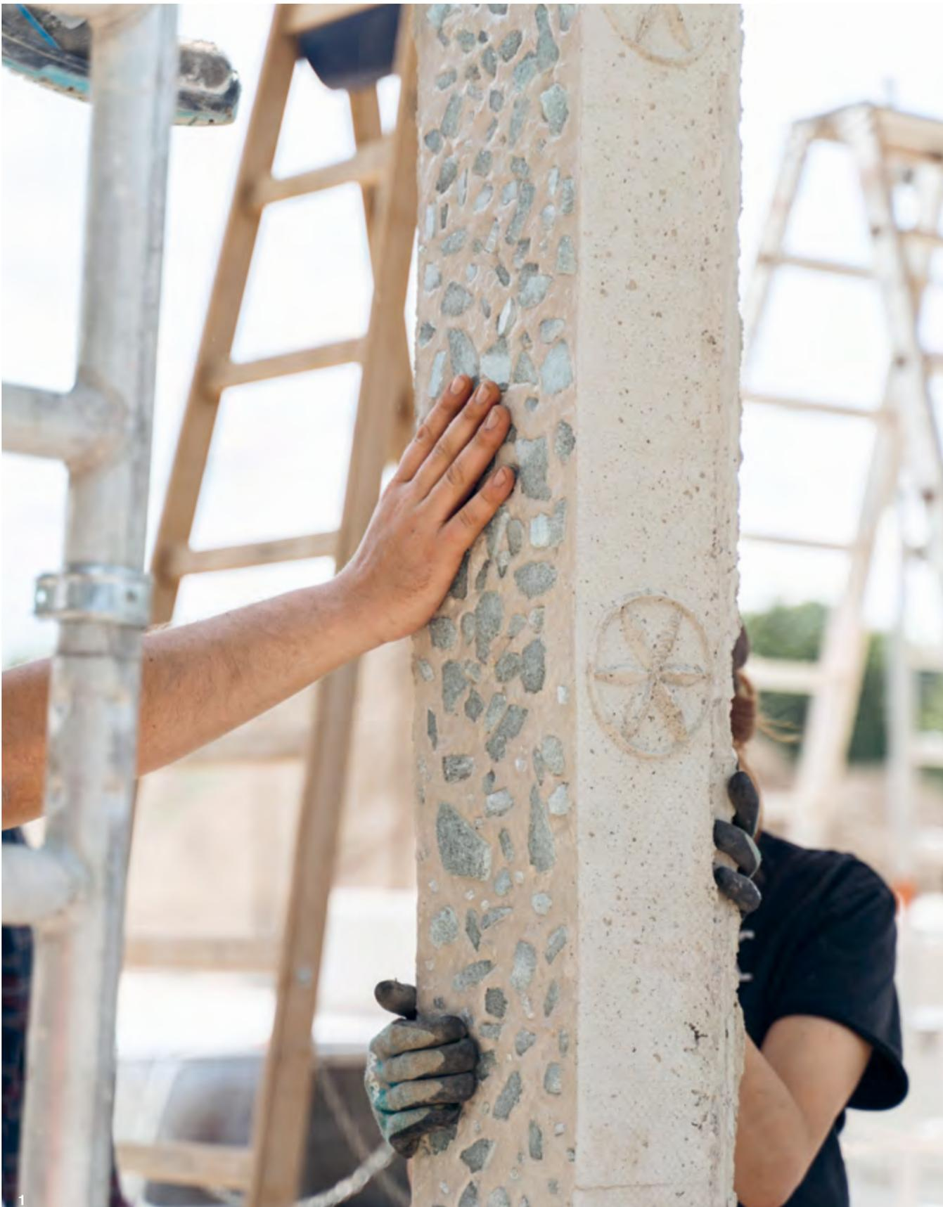
**1** Der Entwurf des Pavillons von Prof. Arthur Wolfrum, Fakultät für Architektur der Hochschule München, ist auch von der Verwendung des Materials beeinflusst. Mit den besonders schlanken Stützen wird gezeigt, welche Bauweisen mit 100%igem R-Beton möglich sind. Die Oberflächen der Stützen wurden von den Studierenden unterschiedlich gestaltet. Damit konnte gezeigt werden, dass sich die Sichtbetonqualitäten eines R-Betons nicht von denen eines normalen Betons unterscheiden.
