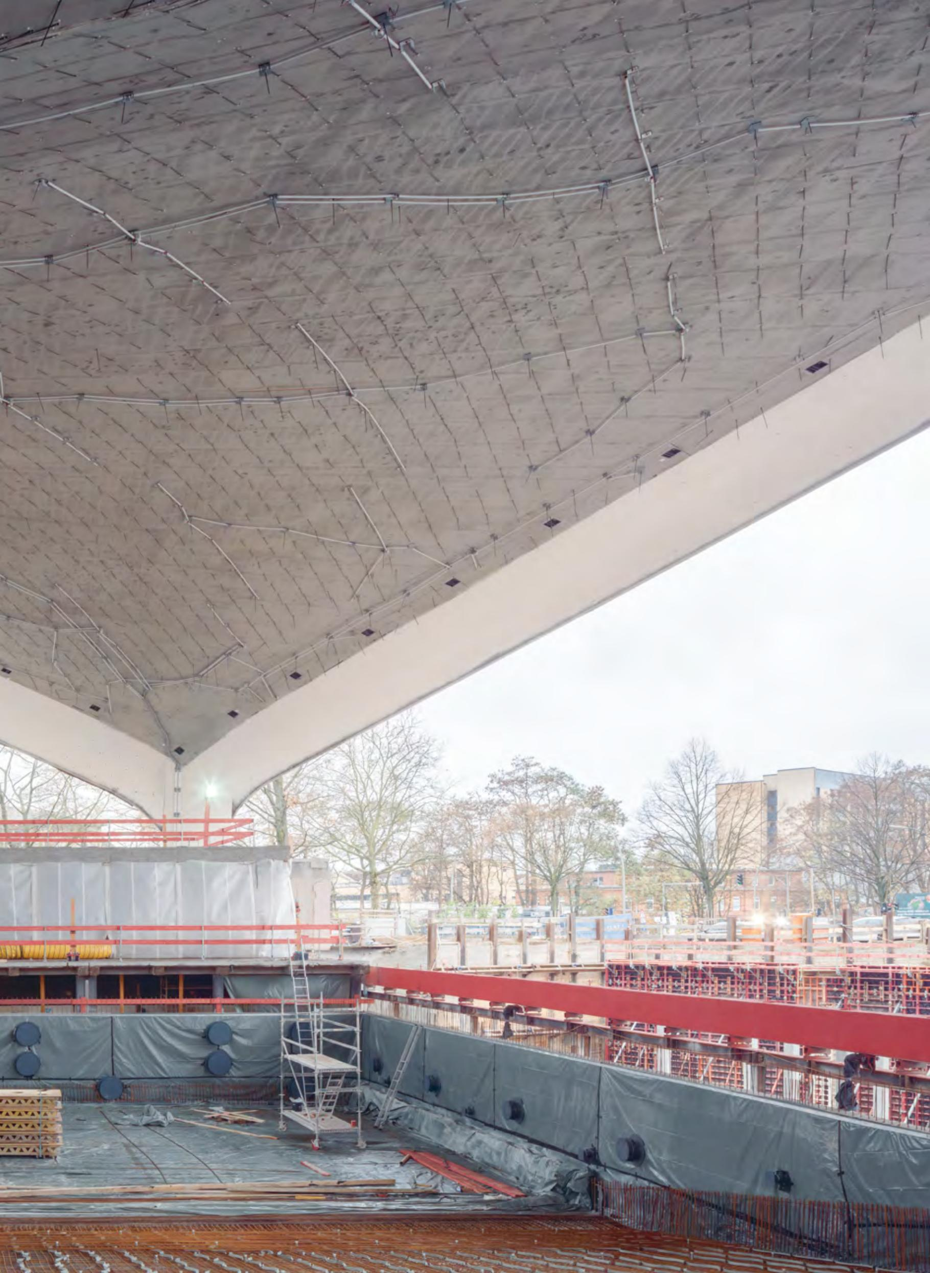
und Partner, den Carbonbeton-Spezialisten von Carbocon aus Dresden und dem Institut für Massivbau an der TU Dresden unmöglich gewesen wäre. Bei der Sanierung wurde ein spezielles Verfahren entwickelt, mit dem das durch Korrosion gefährdete Schalendach an der Innen- und Außenfläche mit Carbonbeton als einem besonders flexiblen Verbundwerkstoff verstärkt werden konnte.
