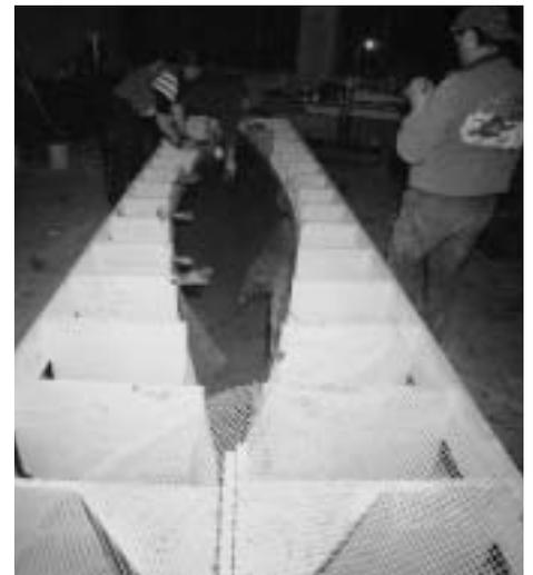
Bild 1.17: Im Bugbereich steht die Anschlussbewehrung heraus
