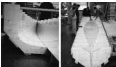
Bild 1.7a und Bild 1.7b: Verspannen der fertigen Schalungsteile
