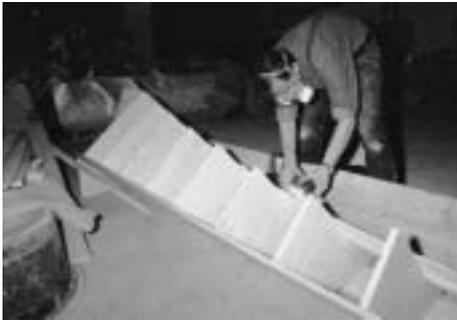
Bild 1.10: Wiederholtes Schleifen der Schalungsoberfläche
