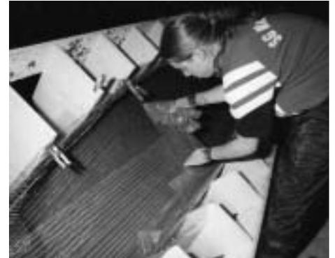
Bild 1.16: Als Längsbewehrung wurden Glasfaserstränge verwendet
