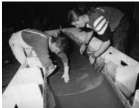
Bild 1.15: Einarbeitung der Rissbewehrung in Querrichtung
