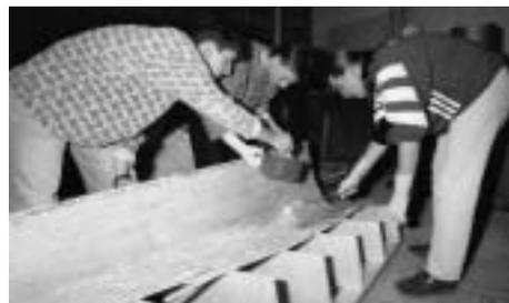
Bild 1.9: Nach Tränkung der Glasfaser mit Epoxidharz wird diese an die Schalungsoberfläche mittels Rollen angedrückt.
