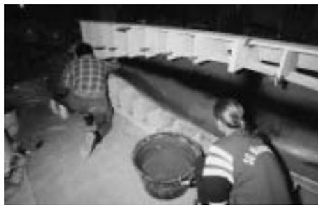
Bild 1.14: Verarbeitung des spachtelfähigen Betons auf der grünen Trennlackschicht
