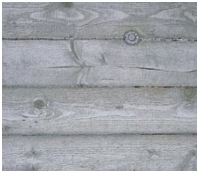
Bild 1: Brettstruktur sägerau, ungehobelte Bretter
