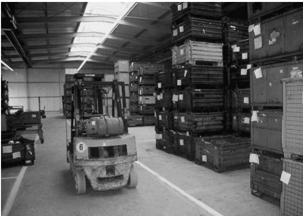
Bild 1: Industrieboden aus Beton mit Staplerverkehr
