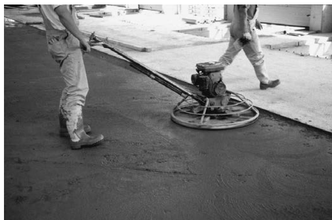
Bild 6: Maschinelles Abscheiben der Betonoberfläche
