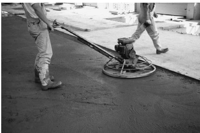
Bild 6: Maschinelles Abscheiben der Betonoberfläche
