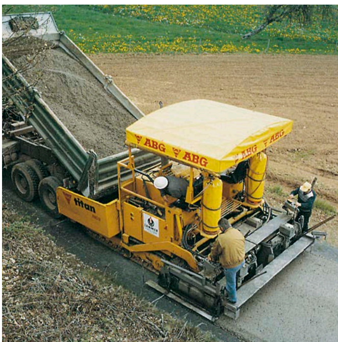
Bild 8: Einbau einer HGTD mit einem Straßenfertiger
