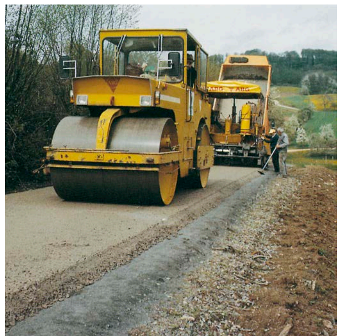
Bild 9: Walzen einer HGTD
