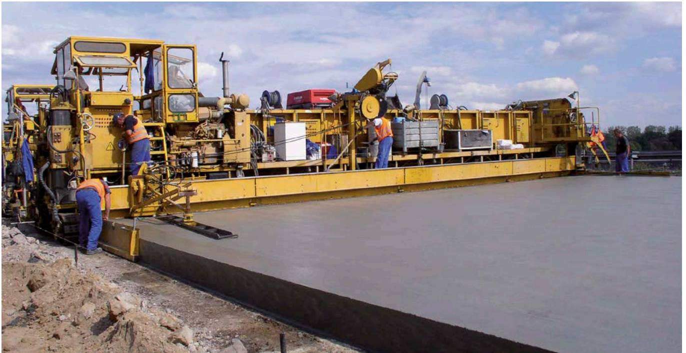
Bild 4: Glätten der fertig eingebauten Betondecke
