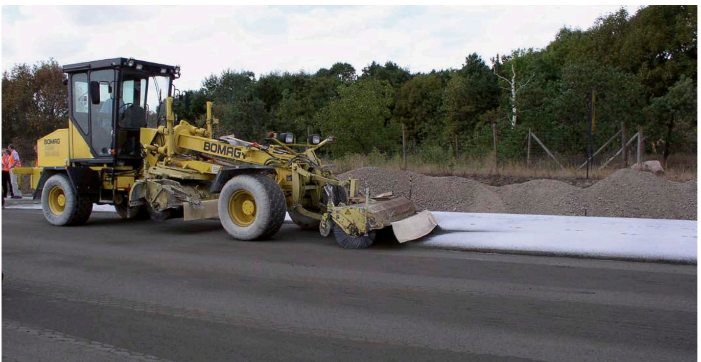
Bild 5: Ausbürsten des Oberflächenmörtels im Nassverfahren
