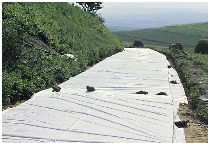
Bild 8: Nachbehandlung der Betondecke durch Abdecken mit Folien
