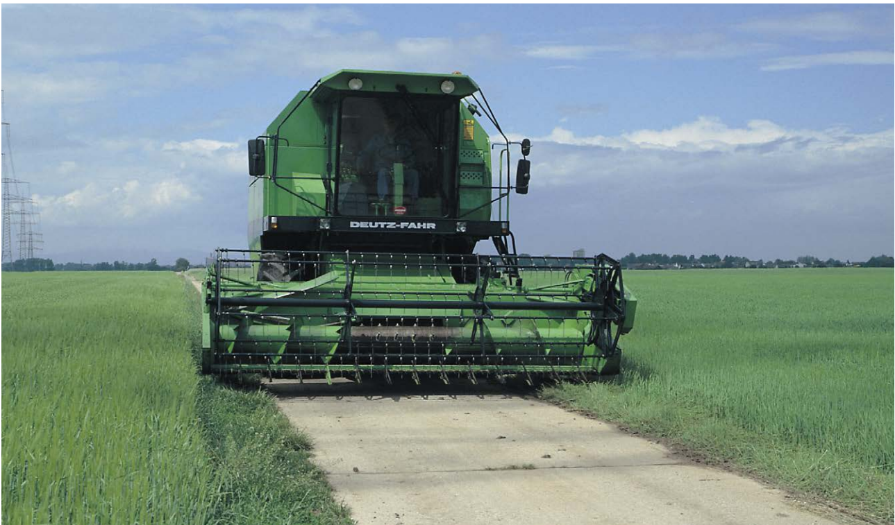
Bild 1: Wirtschaftsweg mit Betondecke
