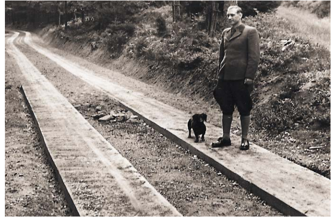
Bild 10: Spurwegebau vor 50 Jahren
