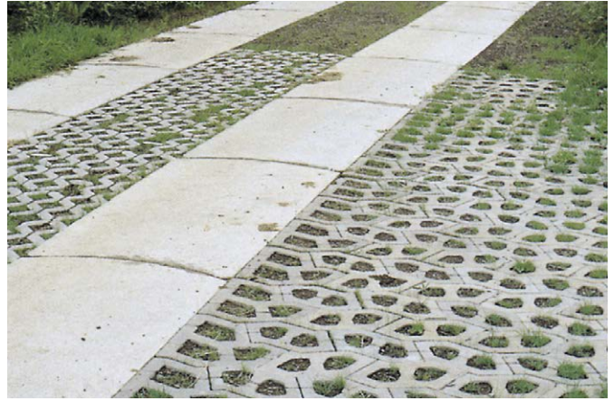
Bild 14: Weg mit Spurplatten, Abzweig mit Rasengitter- und Rasenverbundsteinen befestigt
