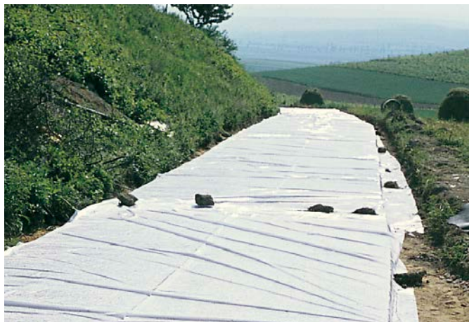
Bild 8: Nachbehandlung der Betondecke durch Abdecken mit Folien
