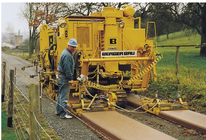
Bild 13: Einbau von Betonspuren mit einem Gleitschalungsfertiger
