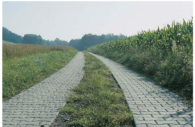
Bild 15: Spurweg aus Betonpflastersteinen mit Verbund
