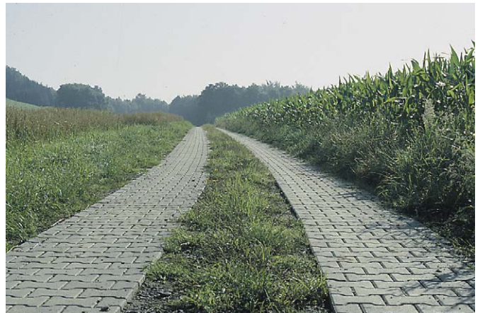
Bild 15: Spurweg aus Betonpflastersteinen mit Verbund
