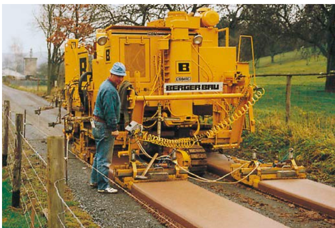
Bild 13: Einbau von Betonspuren mit einem Gleitschalungsfertiger
