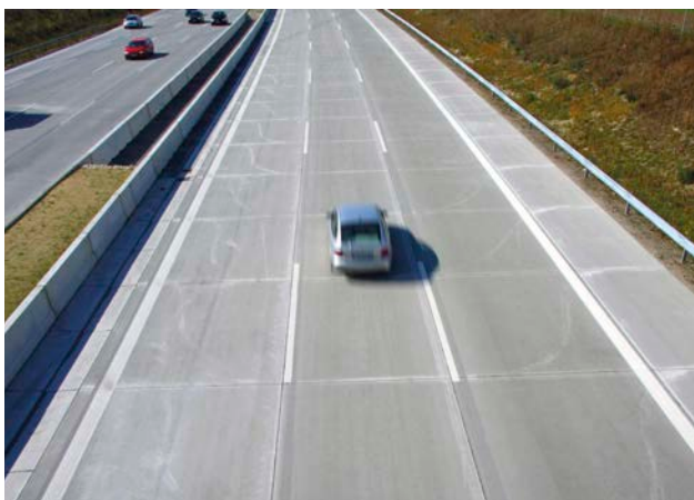
Bild 1: Betonfahrbahndecke im Fernstraßenbau
