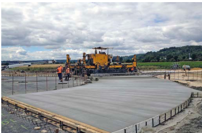
Bild 7: Herstellung einer Beton-Kreisverkehrsfläche mit Fertiger
