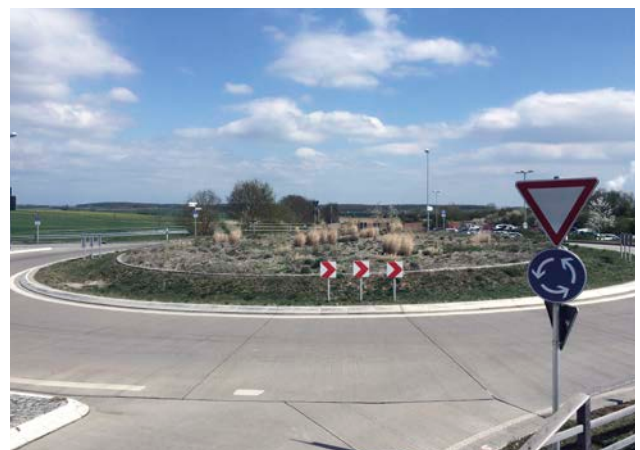
Bild 2: Betonfahrbahndecke im kommunalen Straßenbau
