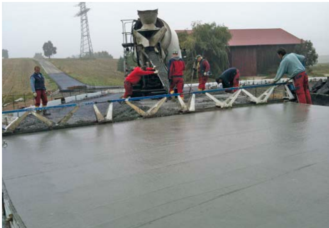
Bild 6: Herstellung einer Beton-Kreisverkehrsfläche im Handeinbau mit Rüttelbohle
