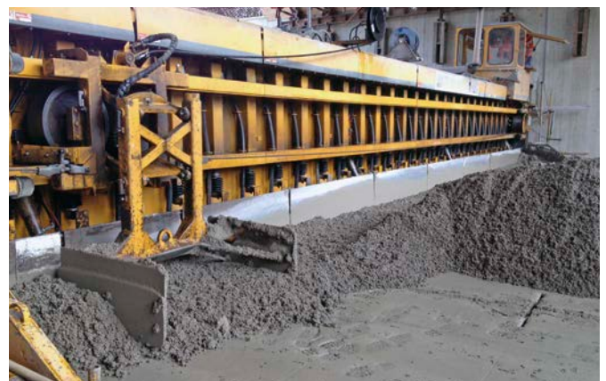
Bild 3: Einbau des Oberbetons, zweischichtige Bauweise
