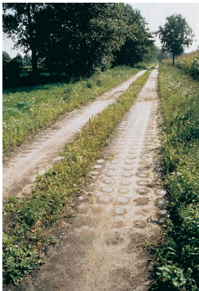
Bild 8: Spurfahrt aus Öko-Pflastersteinen mit Geogitterverbund
