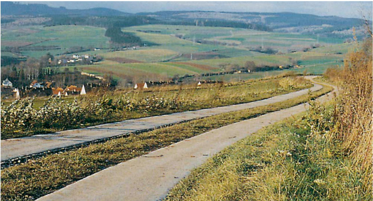
Bild 1: Spurweg aus Ort beton
