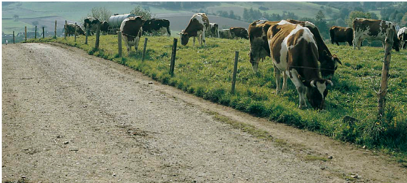
Bild 9: Naturnaher Weg mit hydraulisch gebundener Tragdeckschicht (HGTD)
