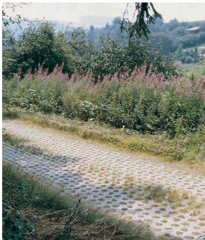
Bild 6: Mit Rasenverbundsteinen befestigter Weg
