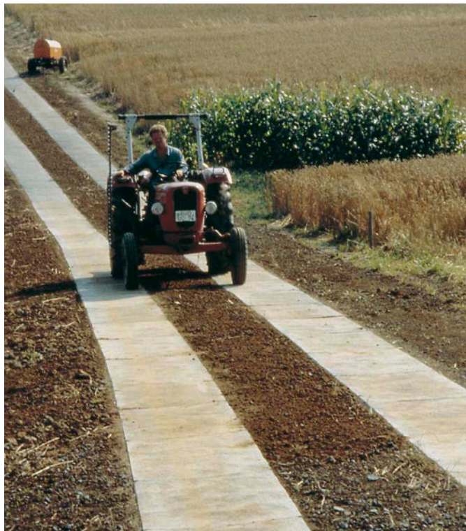
Bild 2: Mit Spurplatten befestigter Spurweg
