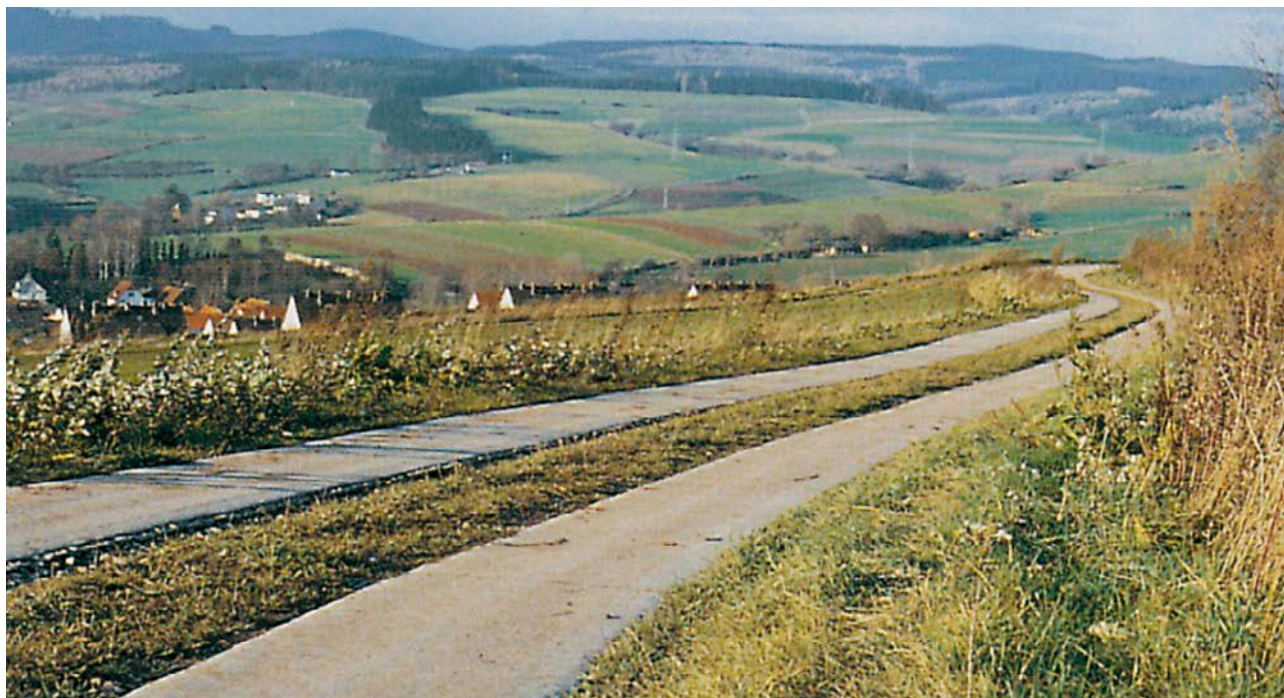
Bild 1: Spurweg aus Ort beton
