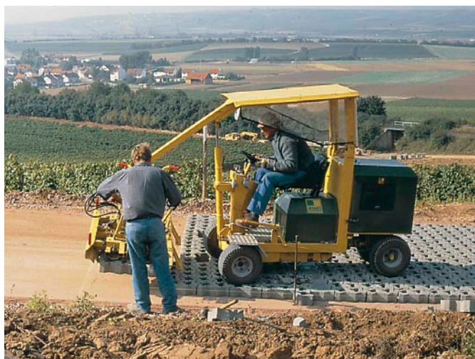
Bild 4: Verlegen von Rasenverbundsteinen mit Verlegemaschine
