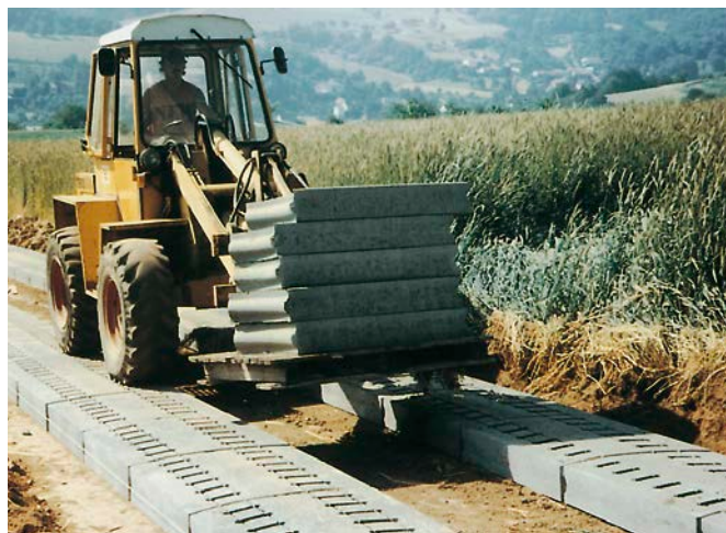
Bild 3: Verlegen von gelochten Spurplatten
