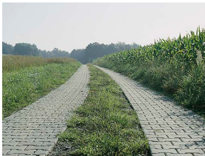
Bild 5: Spurweg aus Verbundsteinpflaster
