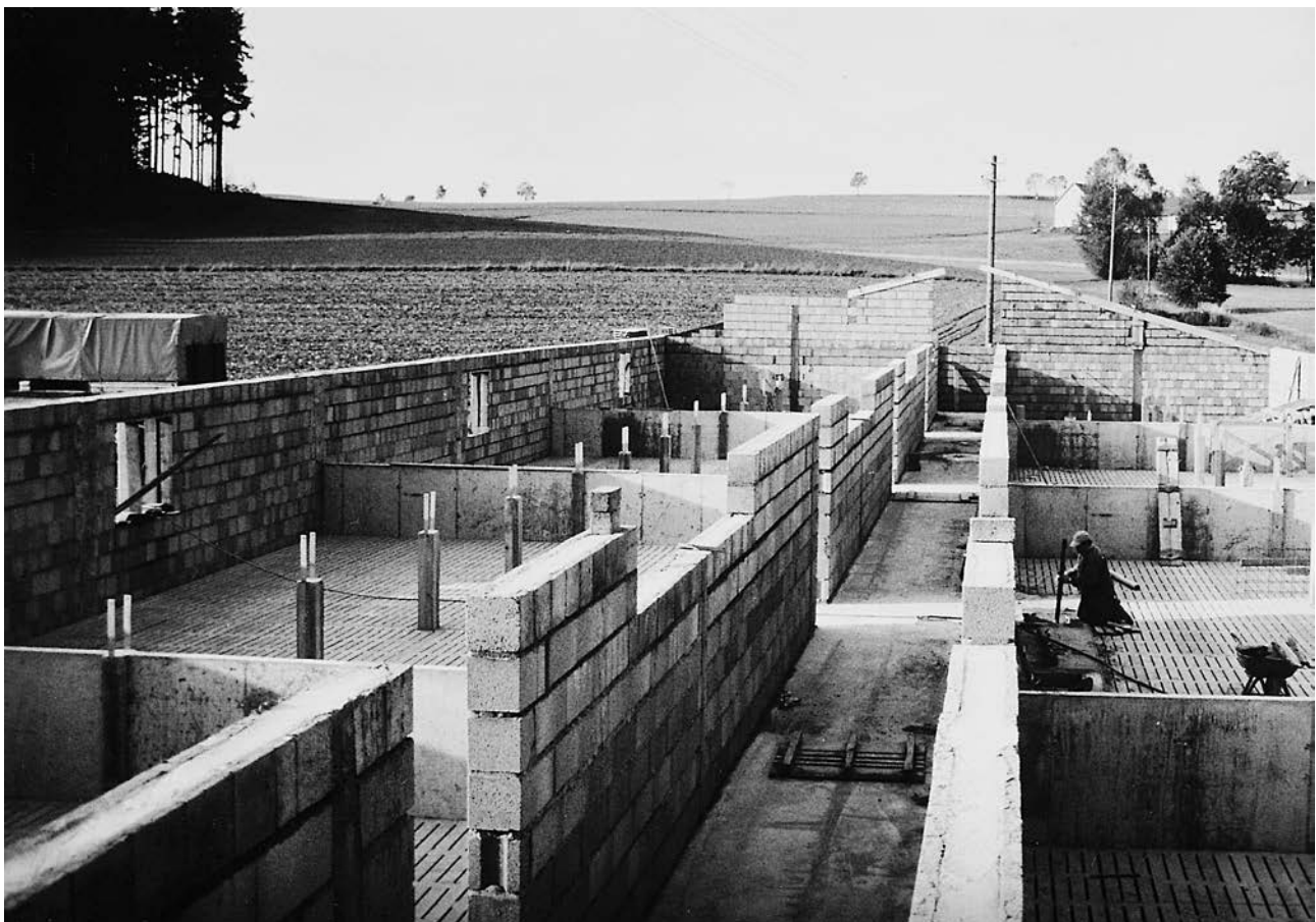
Bild 1: Schweinestall im Bau mit Außenwänden aus Leichtbetonsteinen
