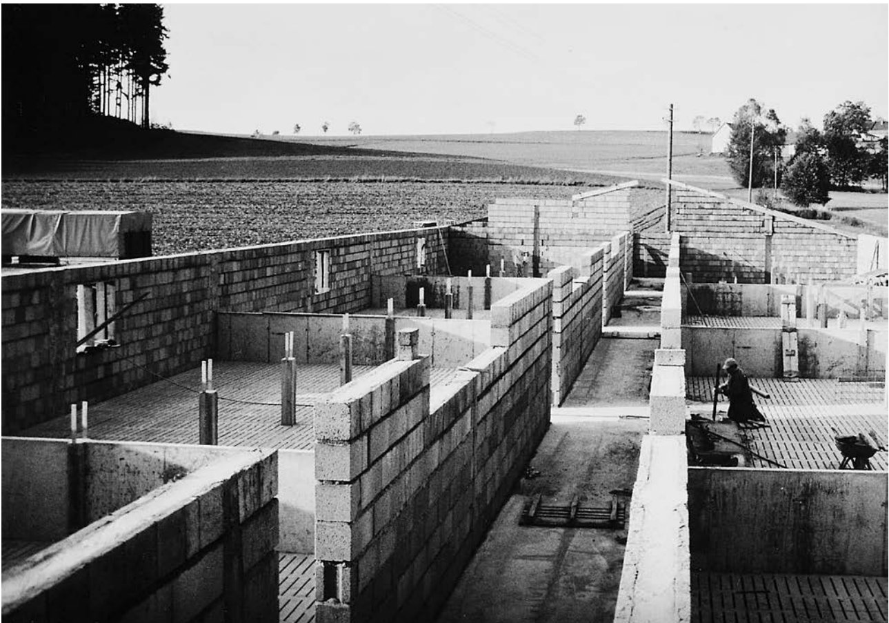
Bild 1: Schweinestall im Bau mit Außenwänden aus Leichtbetonsteinen
