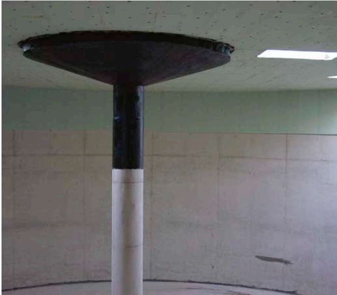
Bild 6: Beschichtung und Wärmedämmung im Fermentergasraum
