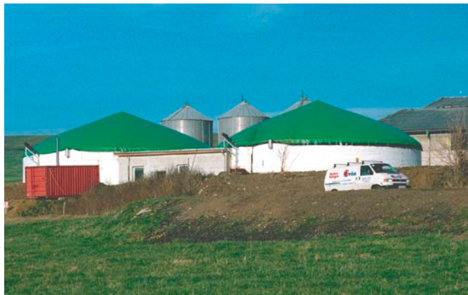
Bild 2: Biogasfermenter mit Foliendach
