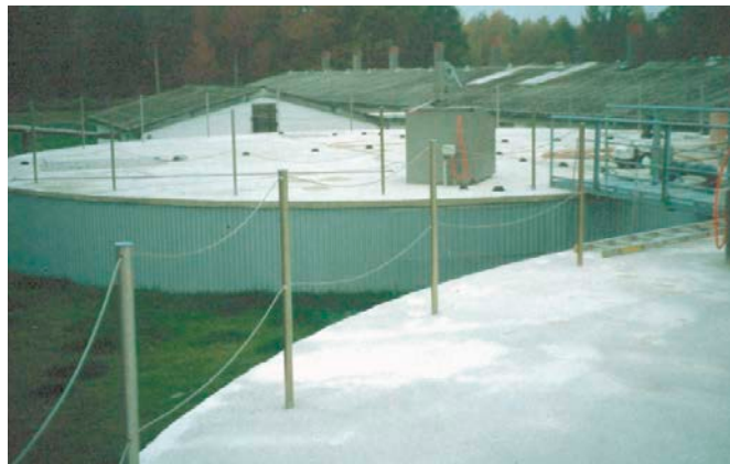
Bild 3: Biogasfermenter mit Betondecke
