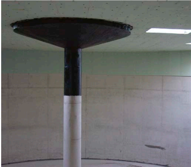
Bild 6: Beschichtung und Wärmedämmung im Fermentergasraum
