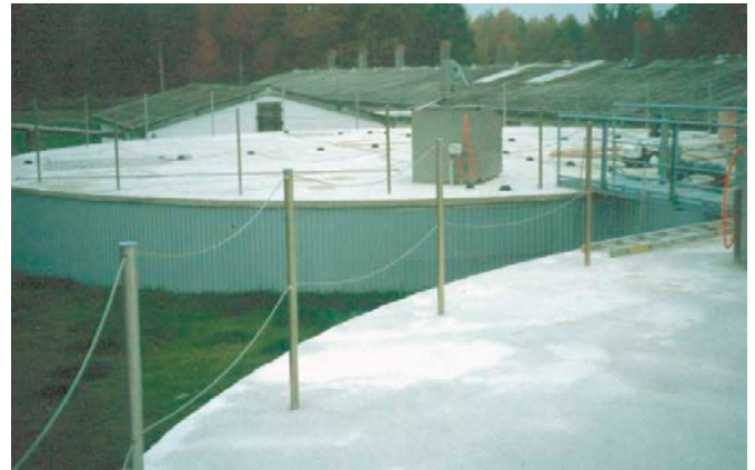
Bild 3: Biogasfermenter mit Betondecke
