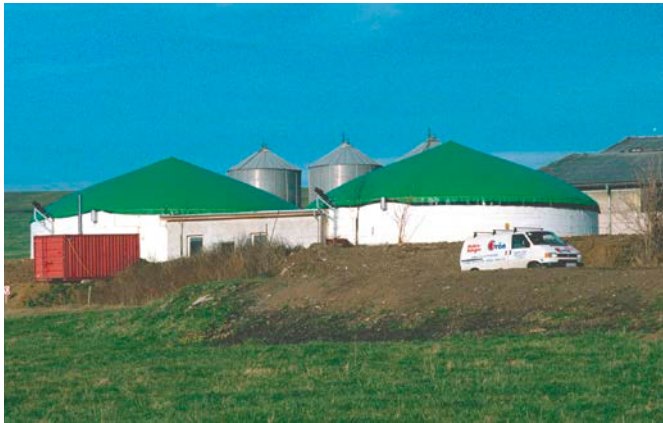
Bild 2: Biogasfermenter mit Foliendach
