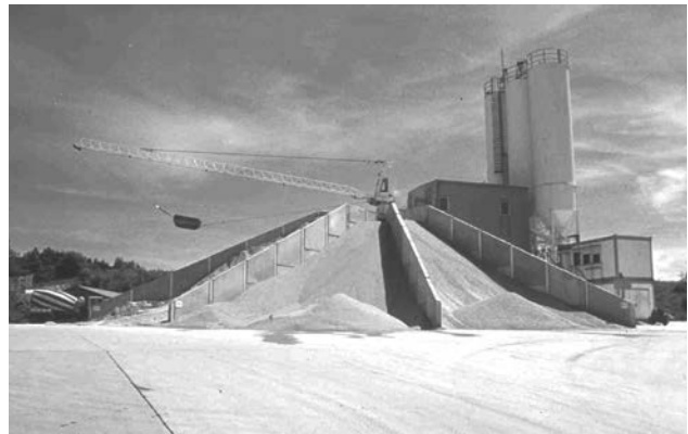
Bild 2: Vorbildlich ausgestattete Mischanlage
