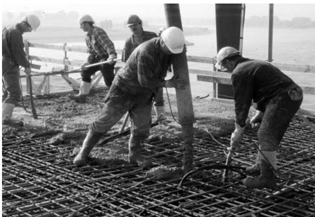
Bild 1: Verarbeiten von Beton auf der Baustelle
