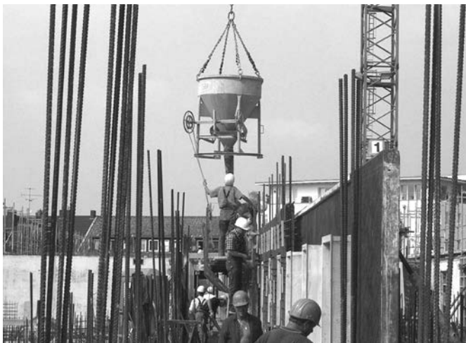
Bild 3: Fördern des Betons mit dem Kübel
