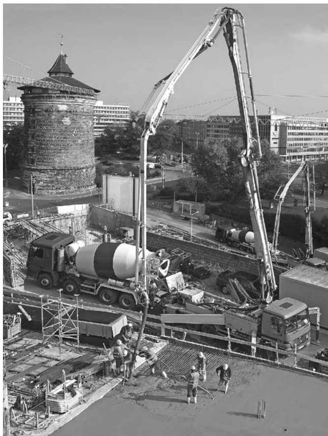
Bild 4: Fördern und Einbringen des Betons mit der Pumpe
