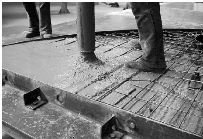
Bild 5: Herstellen eines Deckenelements aus SVB (aus [10])
