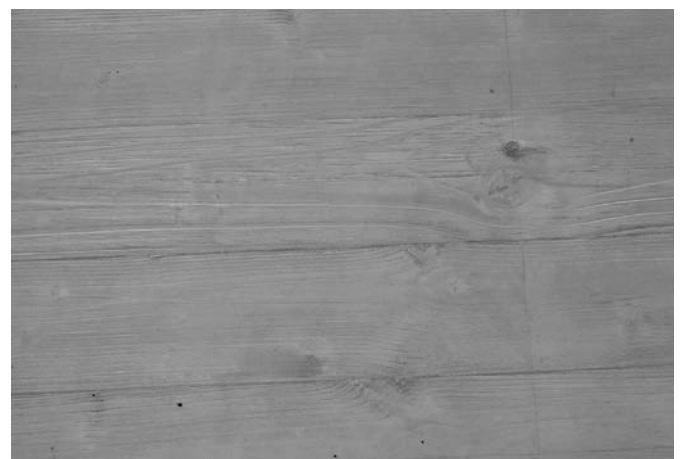
Bild 7: Mit SVB hergestellte Ortbetonwand in Frankfurt (aus [10])
