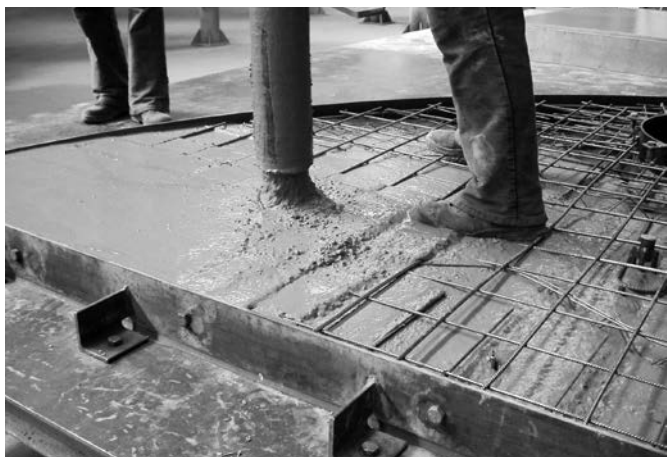
Bild 5: Herstellen eines Deckenelements aus SVB (aus [10])
