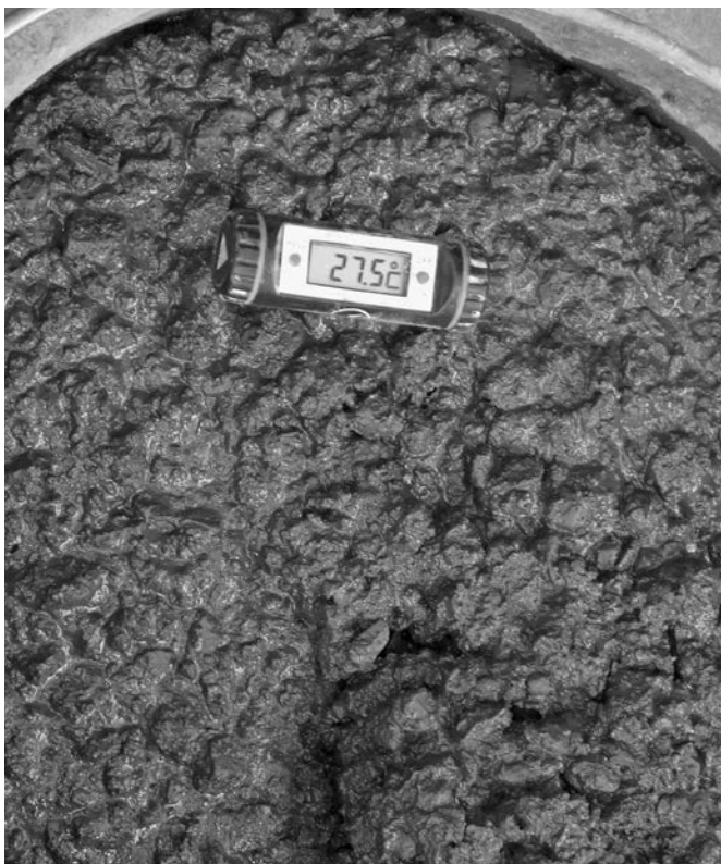
Bild 7: Vermehrte Kontrolle der Frischbetontemperatur auch nach Probekörperherstellung
