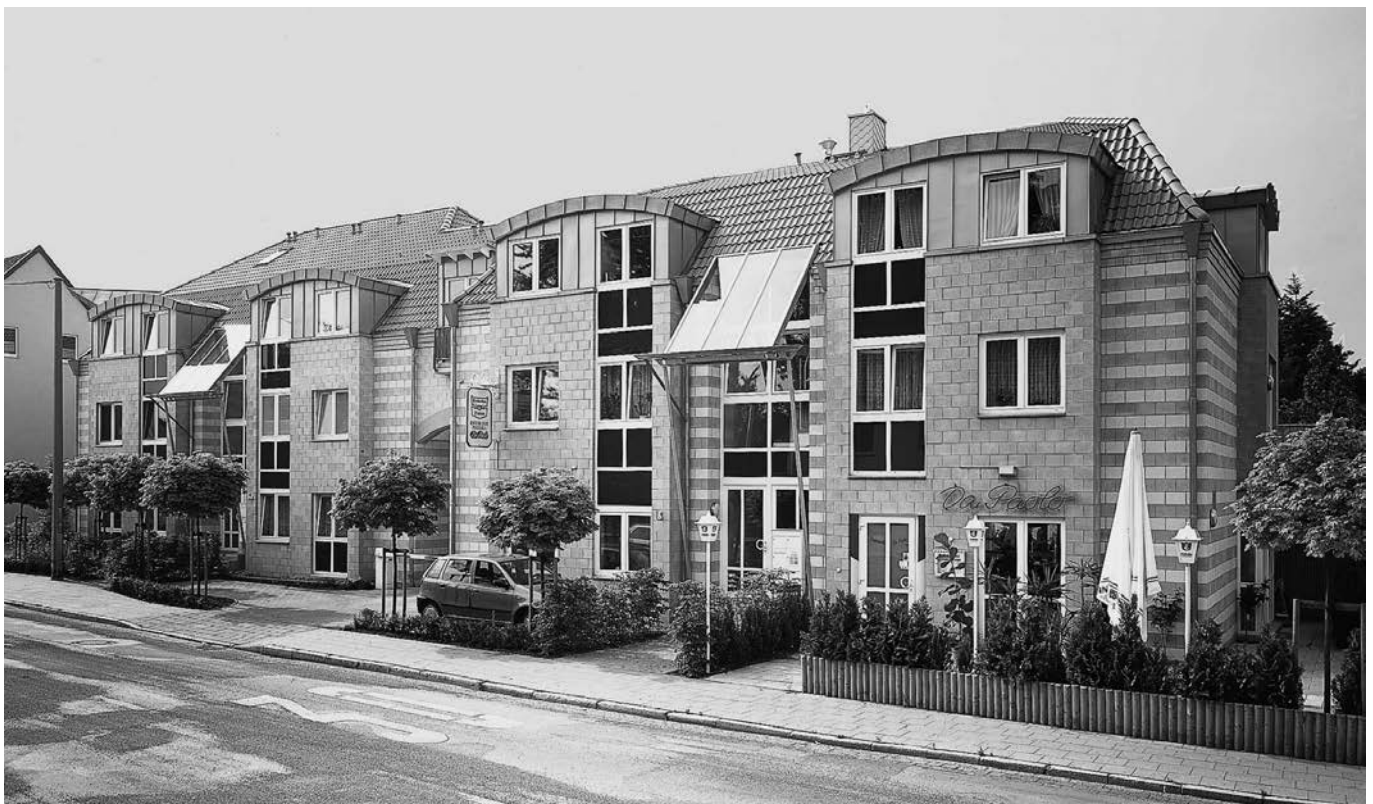
Bild 4: Bauwerk aus Leichtbeton
