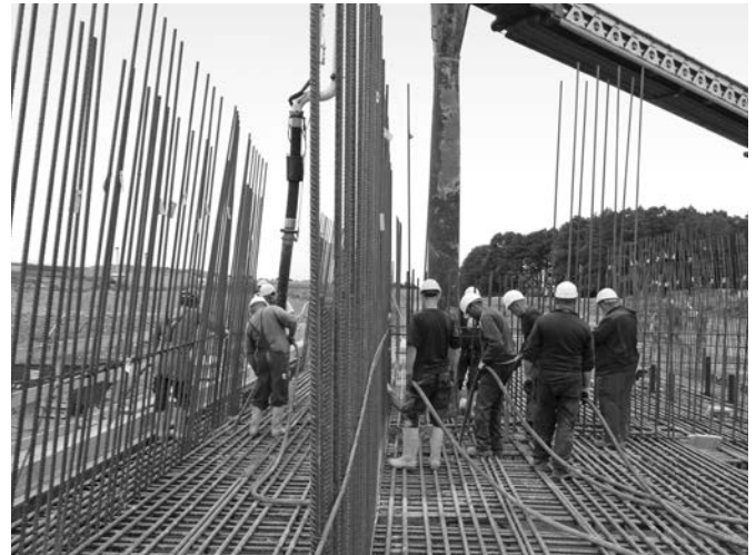
Bild 10: Fundament eines Hochwasserrückhaltebeckens in zonierter Bauweise, links im Bild wird der Randbeton C30/37 (auf Grund der Expositionsklasse XA2) und rechts der Kernbeton mit geringer Festigkeits- und Wärmeentwicklung eingebaut (Foto: A. Weisner).
