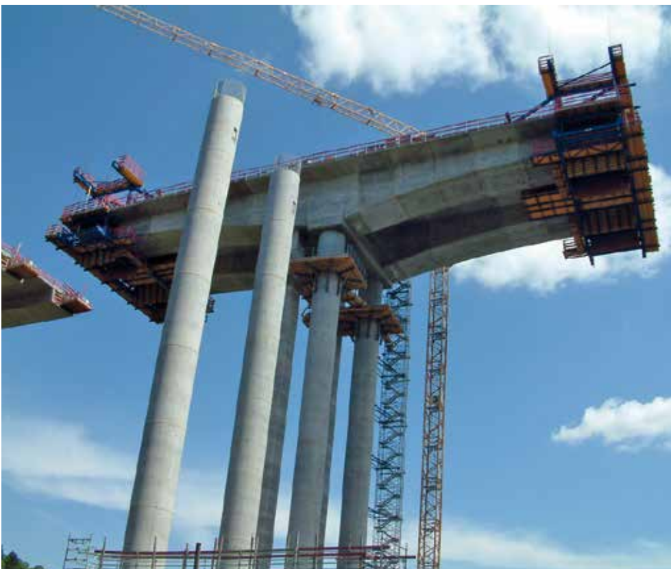
Bild 6: Lahntalbrücke bei Limburg im Bau
