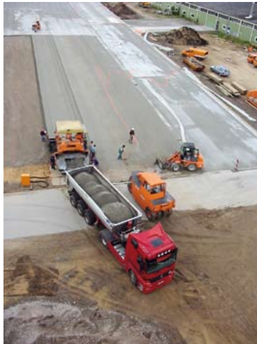
Bild 3: Walzbetoneinbau in Bahnen [1]
