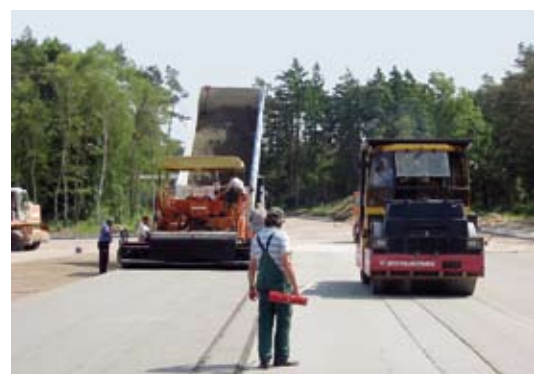
Bild 2: Abwalzen mit einer 16-t-Glattmantelwalze [1]
