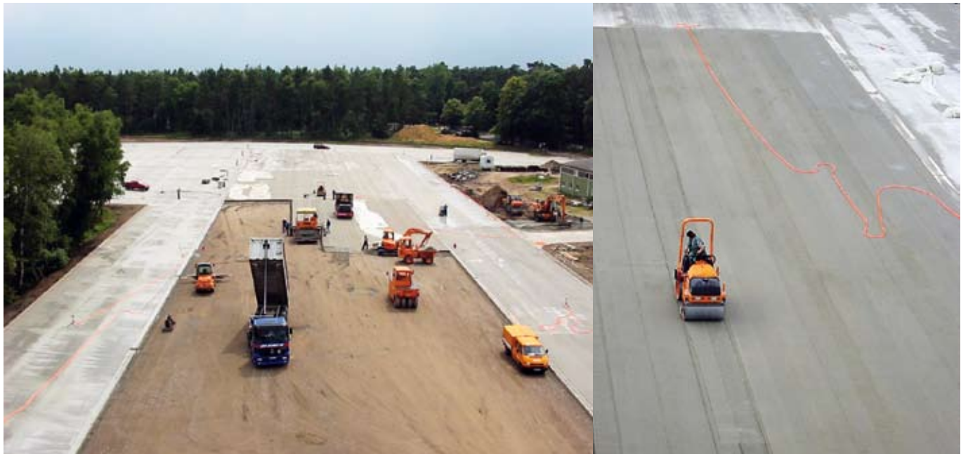
Bild 1: Walzbetoneinbau im Materialdepot Hesedorf [1]
