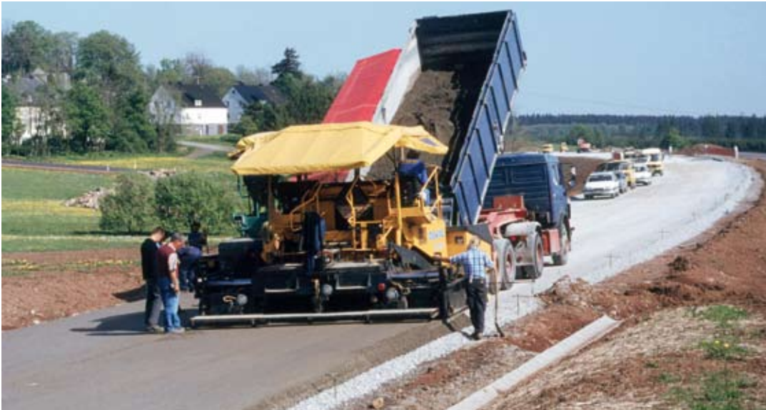
Bild 7: Erprobungsstrecke «Walzbeton als Tragschicht mit dünnem Asphaltbelag» auf der B 54 im Westerwald
