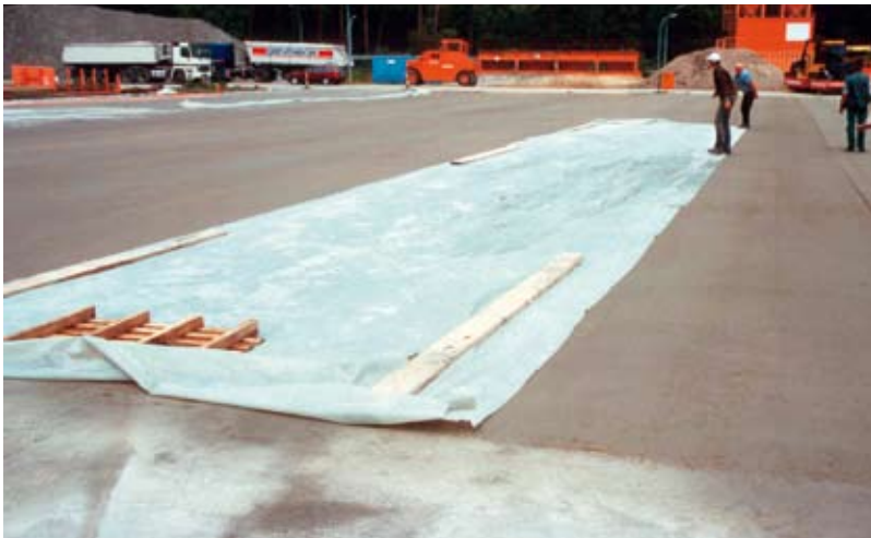
Bild 5: Abdeckung mit Folie bei Regenrisiko [1]
