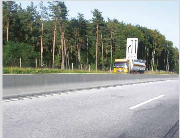
Bild 6: Betonschutzwand mit New-Jersey-Profil
