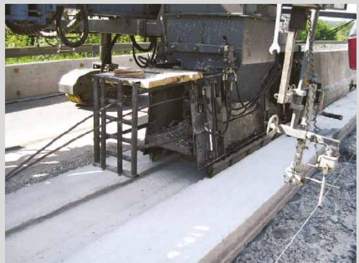
Bild 8: Bau einer eingespannten Betonschutzwand
