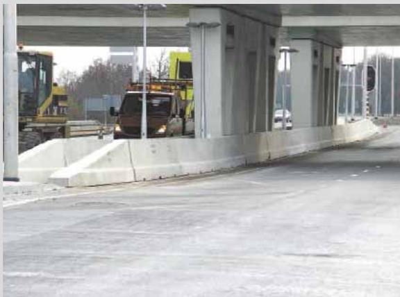
Bild 10: Schutzeinrichtung aus Beton an Brückenpfeilern
