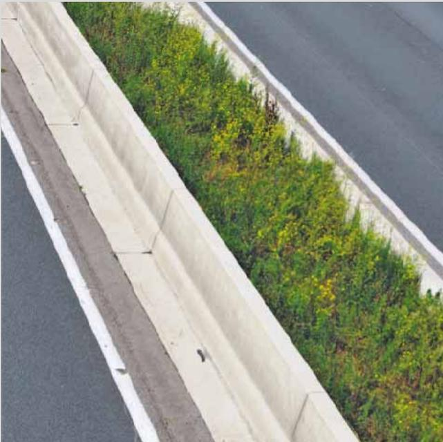
Bild 5: Betonschutzwand mit Step-Profil
