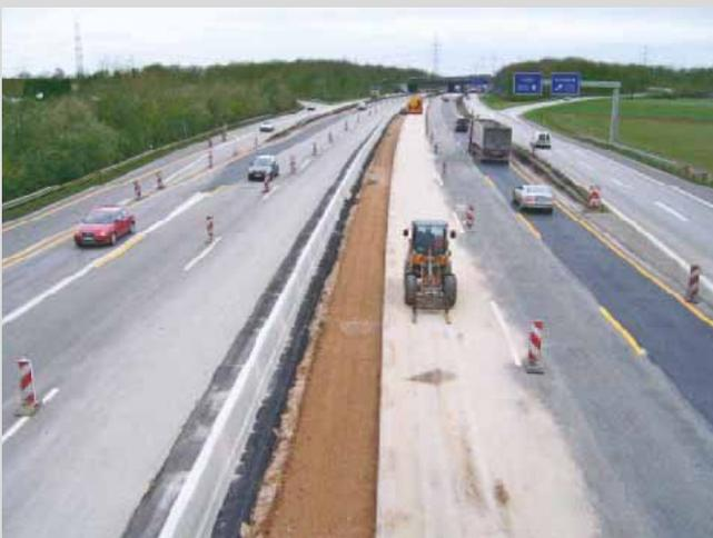
Bild 7: Bau einer frei aufgestellten Betonschutzwand
