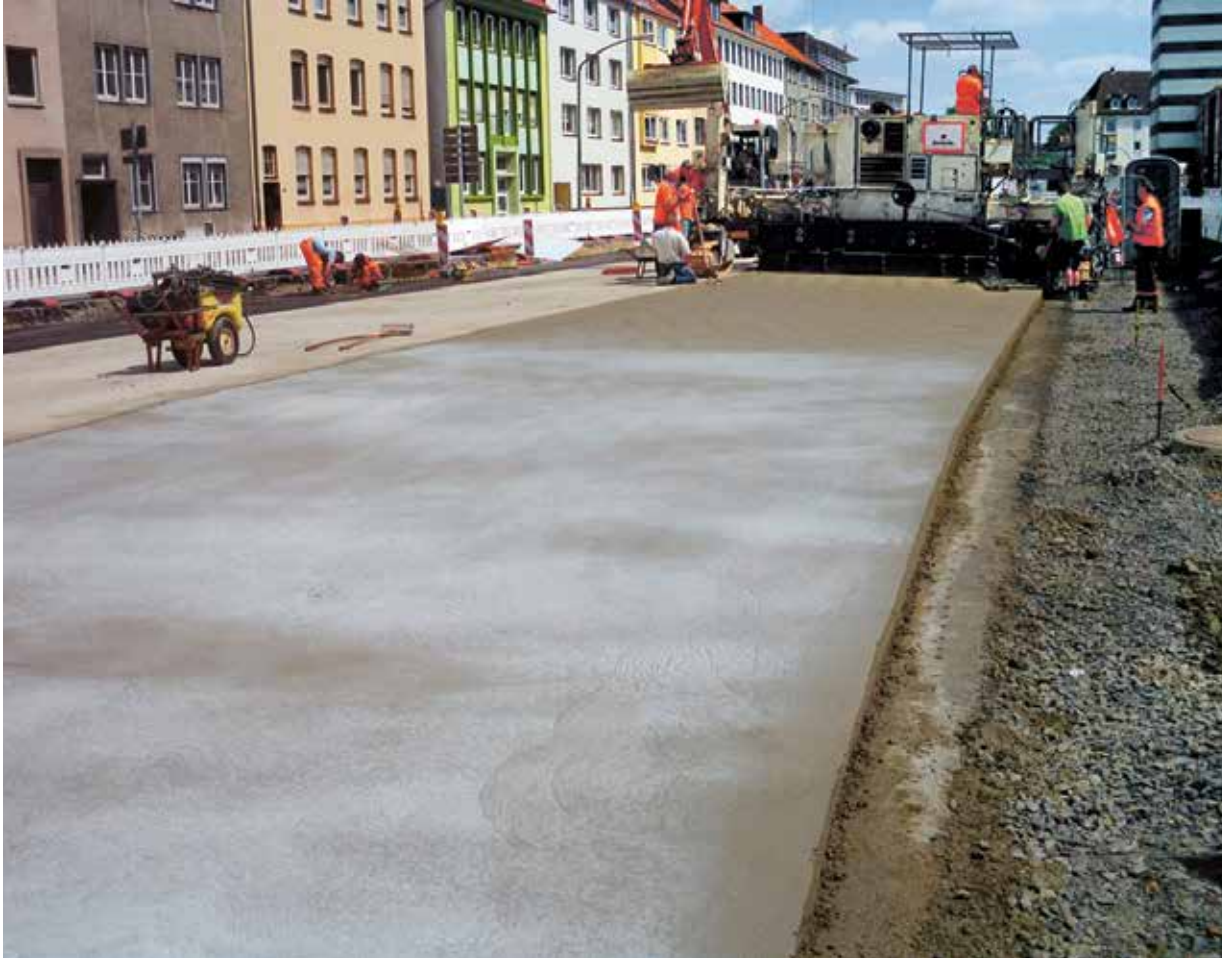
Abb. 6 Herstellen des Unterbetons
