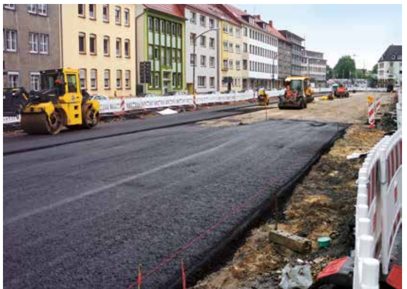
Abb. 5 Asphalttragschicht
