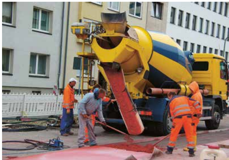
Abb. 7 Einbau des eingefärbten Oberbetons
