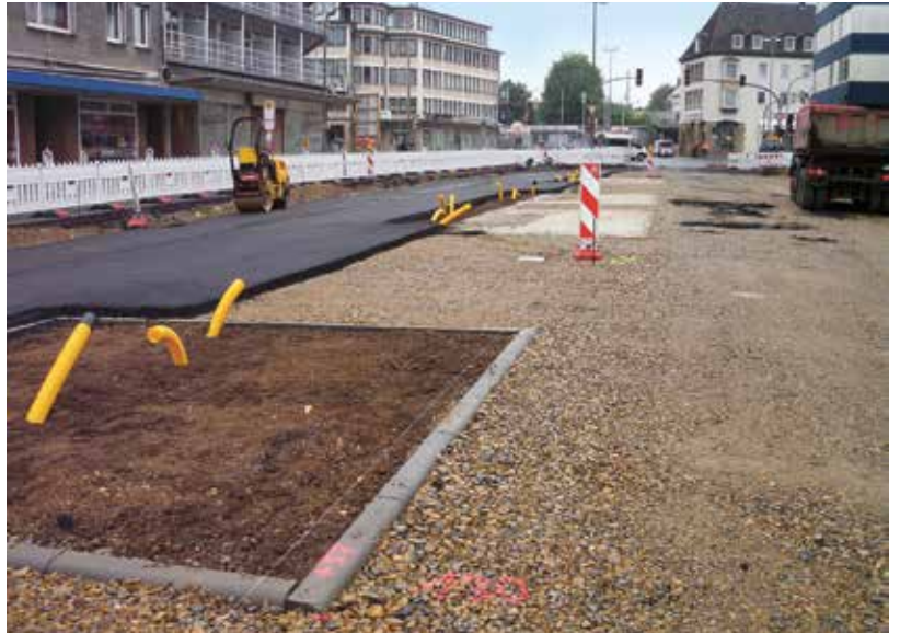
Abb. 4 Bauplanum Frostschuttschicht/Schottertragschicht
