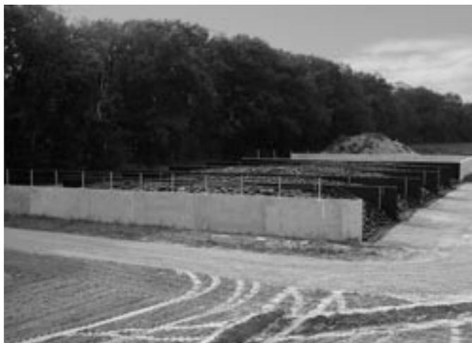
Bild 7: Rückseite der Festmist-Fahrsilo-Kombination mit tragfähiger Umfahrung
