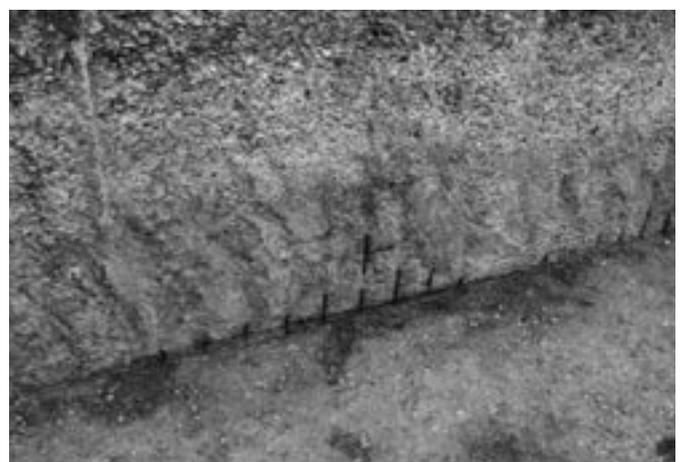
*Bild 3: Gärsäuren können massiv den Beton angreifen – Schutzanstriche / Beschichtungen oder spezielle Betonzusammensetzungen sind für eine lange Lebensdauer unumgänglich*
