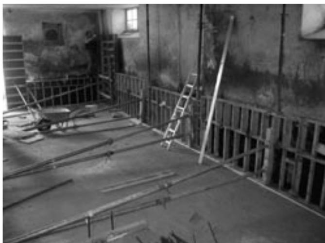
Bild 2: Schalung zum Betonieren der Spaltenbodenauf-
