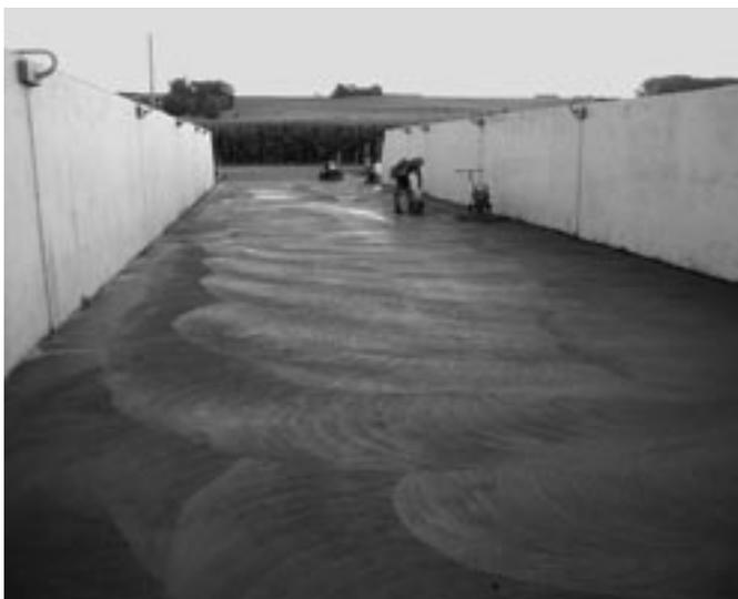
Bild 1: Herstellung der Bodenplatte eines Gärfuttersilos
