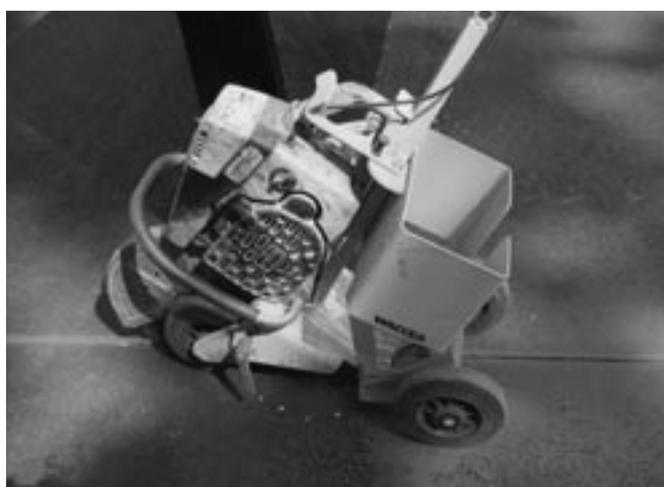
*Bild 6: Schneiden der Scheinfuge*
