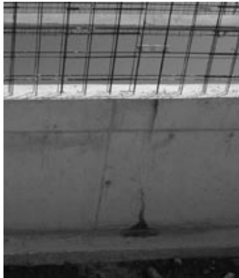
Bild 1: Undichte Stellen werden bei Wasserbefüllung sichtbar
