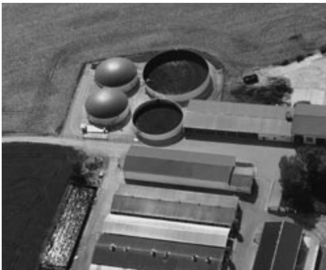
Bild 1: Behälter einer Biogasanlage (Foto HEPOLAN Heeren)
