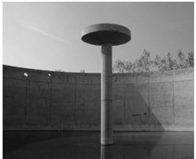
Bild 2: Fermenter mit Mittelstütze
