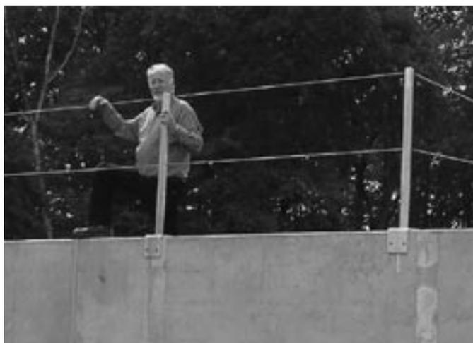
Bild 8: Absturzicherung des Fahrsilos durch Reling
