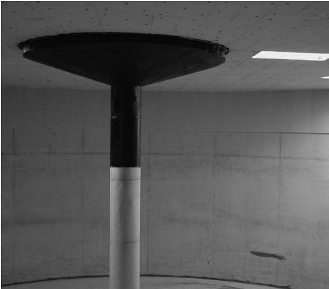
Bild 6: Beschichtung und Wärmedämmung im Fermentergasraum
