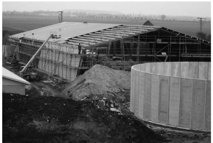
*Bild 5: Umbau eines A-Bock-Silos zur landwirtschaftlichen Mehrzweckhalle*
