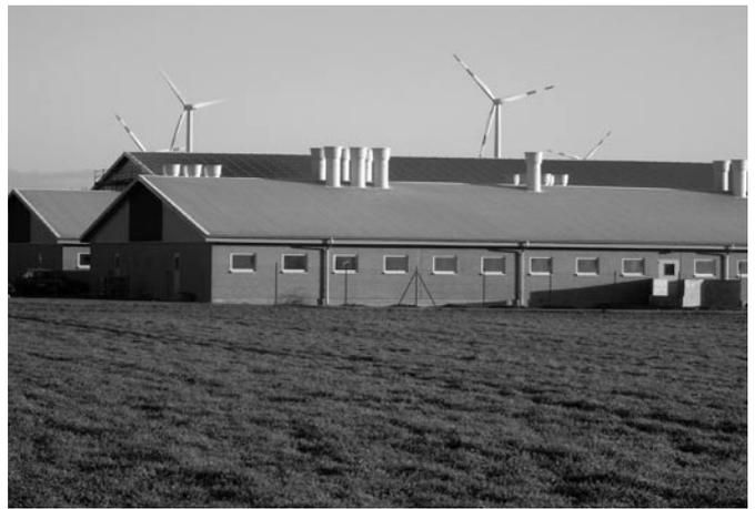
*Bild 4: Schweinemaststall in Beton-Fertigteilbauweise*
