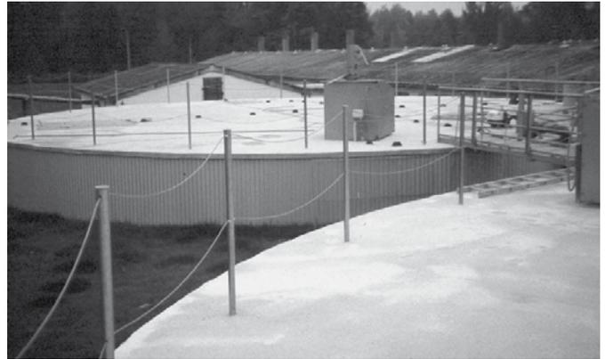
Bild 3: Biogasfermenter mit Betondecke
