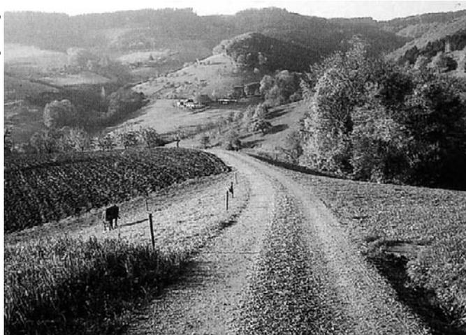
Bild 1: Landschaftsangepasster Weg im Hang mit einer hydraulisch gebundenen Tragdeckschicht (HGTD)
