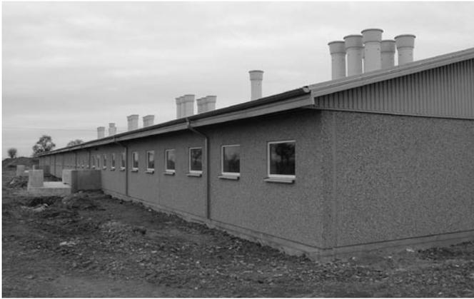
Bild 4: Geschosshohe Betonfertigteile für die Außenwände mit Waschbetonoberfläche
