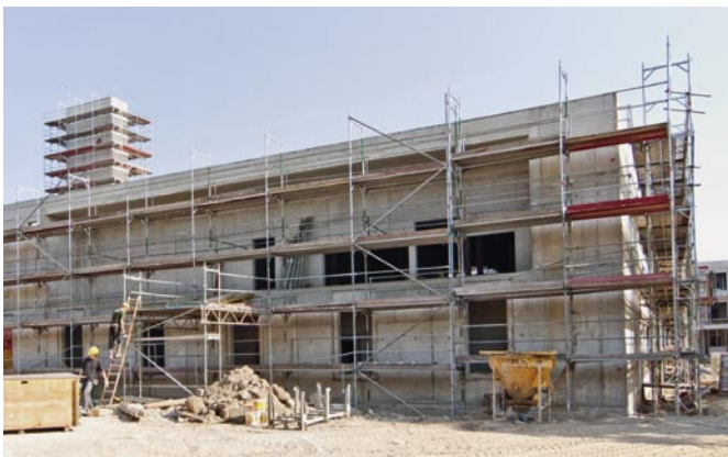
Bild 12: Rohbau Stallgebäude
