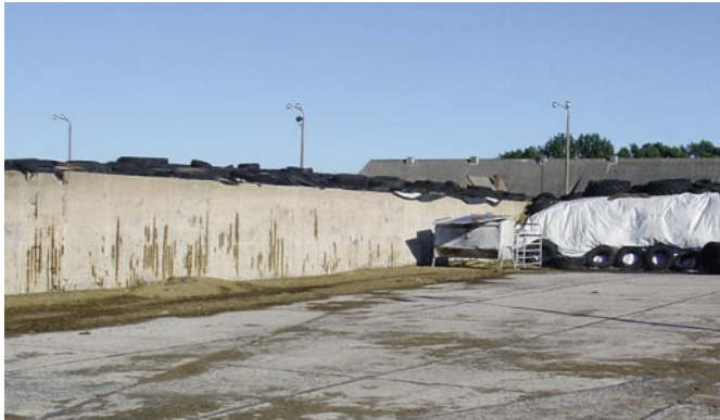
Bild 4: Bewehrungskorrosion durch zu geringe Betondeckung
