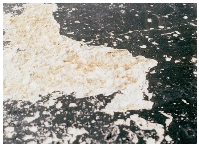
Bild 3: Abplatzende Beschichtung durch ungenügende Untergrundvorbereitung
