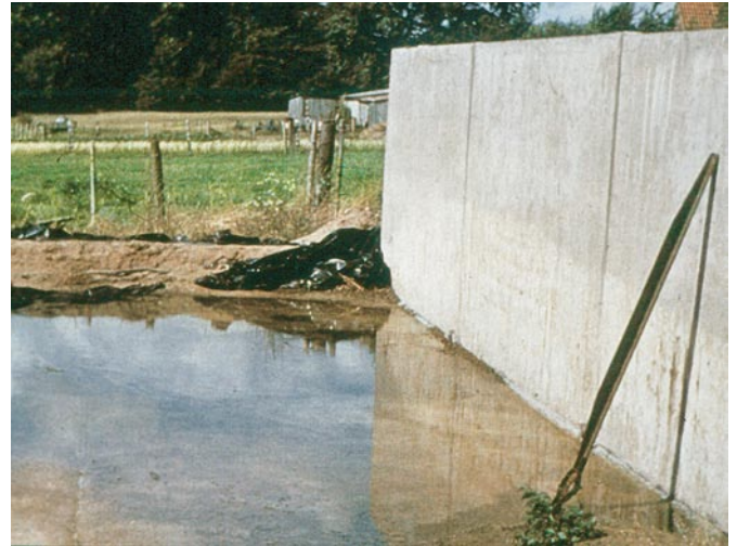
Bild 1: Gärfuttersilo mit fehlendem Gefälle: Sickersaft und Regenwasser durchnässen den Futterstock
