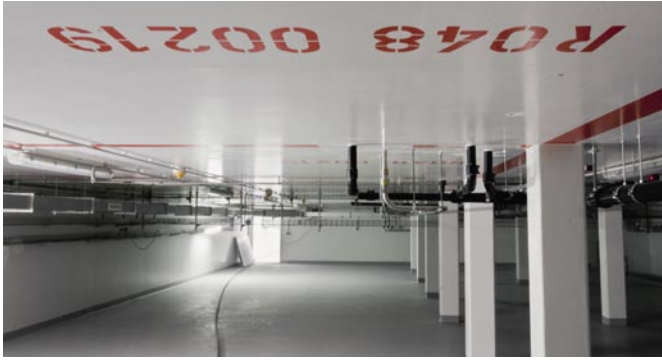
Bild 11: Orientierung im Technikgeschoss: Markierung der Raumgrundrisse des darüberliegenden Nutzergeschosses
