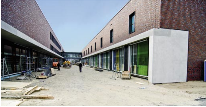
Bild 4: Innere Erschließungsstraße (Magistrale) im Bau
