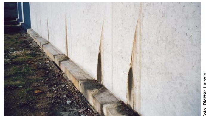
Bild 7: Bei flüssigkeitsführenden Rissen erfolgt bei Gärsäuren keine Selbstheilung.
