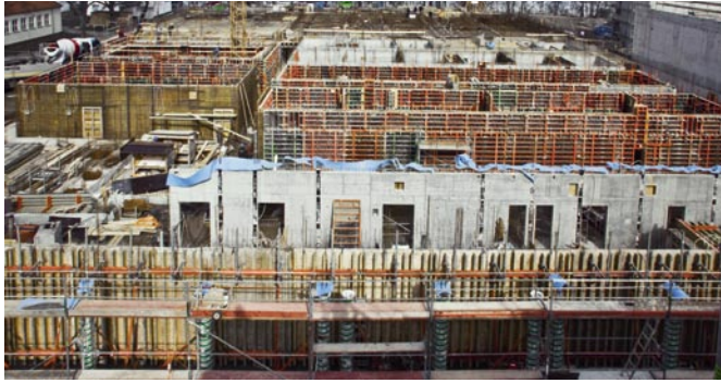
Bild 8: Rohbau Labor- und Stallgebäude
