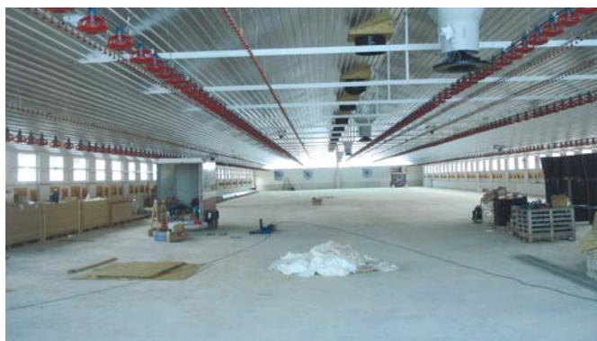
Bild 3: Stall mit fertiggestellter Dachdämmung
