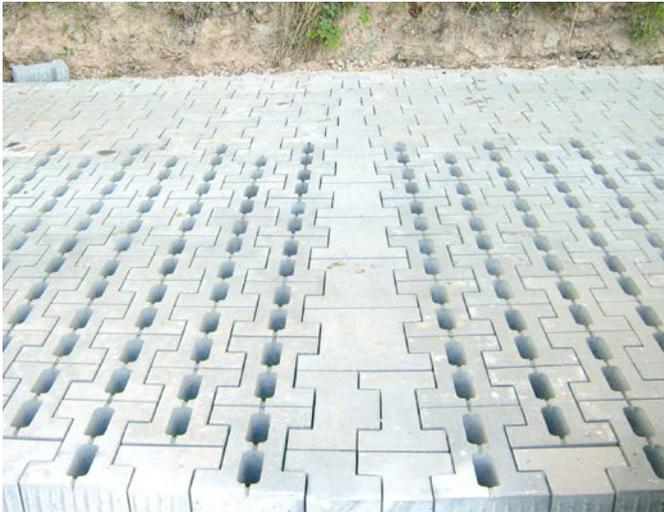
Bild 6: Kombination von Rasenkammersteinen und Vollsteinen
