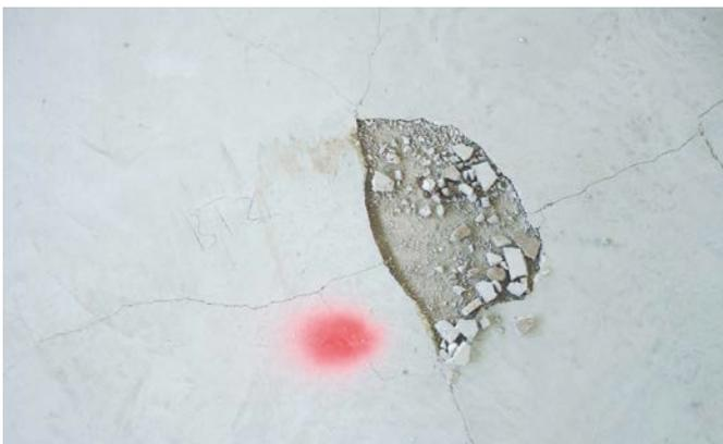
Bild 7: Abplatzen des hohl liegenden Estrichs im Bereich der Rissbildung
