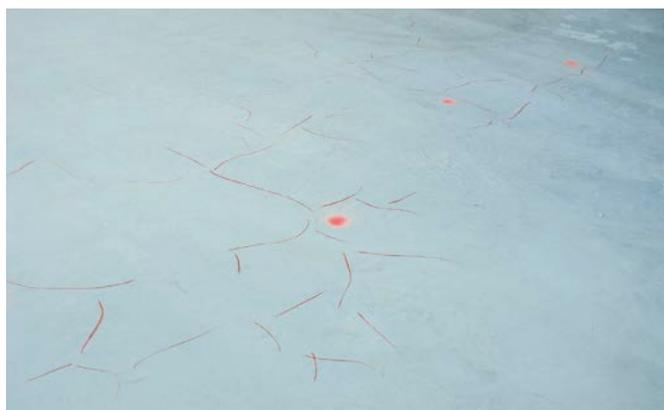
Bild 4: Über den ganzen Stall verteilte Krakeleerisse, nachgezeichnet
