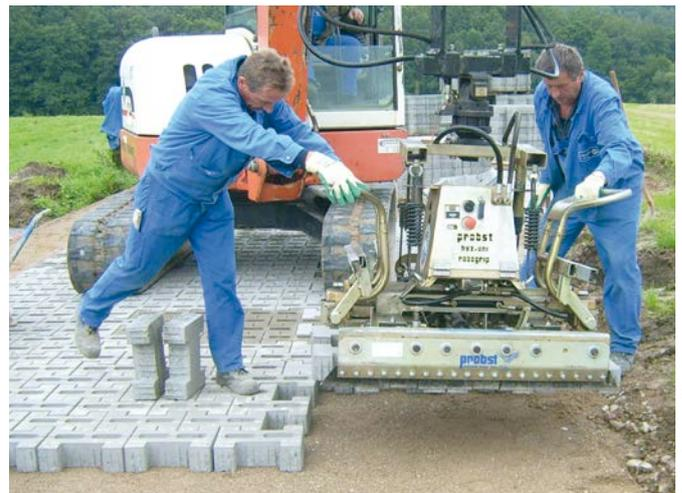
Bild 8: Maschinelle Verlegung des Pflasters
