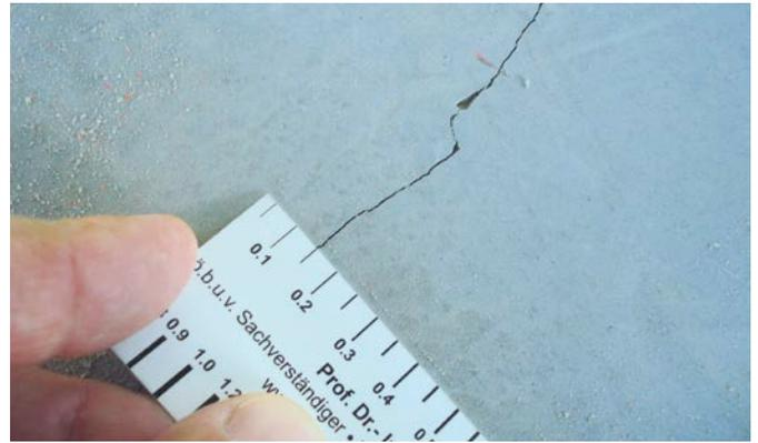
Bild 6: Risse mit Breiten von ca. 0,1 mm bis 0,15 mm
