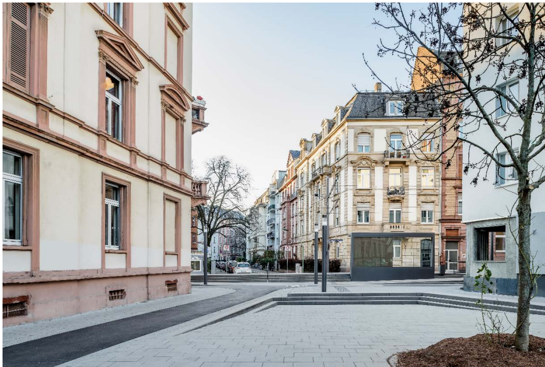
Mit Betonpflaster befestigter Bereich hinter dem Hochbahnsteig Musterschule in Frankfurt/M. Foto: Moritz Bernouilly
