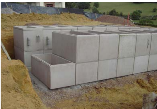
Die Grabkammern lassen sich je nach Platzbedarf mehrfach übereinander stapeln und nach Ablauf der Ruhezeit erneut belegen. Foto: Ackermann/Ökotec
