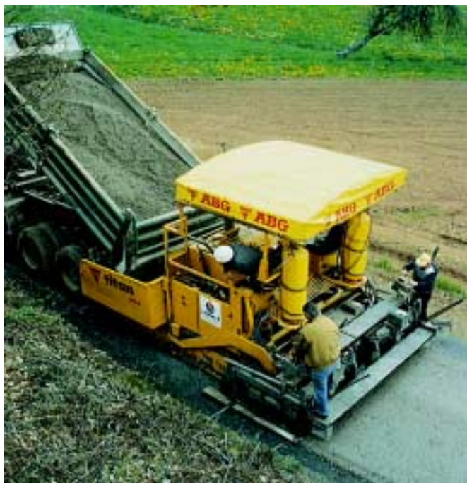
Bild 8: Einbau einer HGTD mit einem Straßenfertiger
