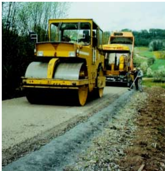
Bild 9: Walzen einer HGTD
