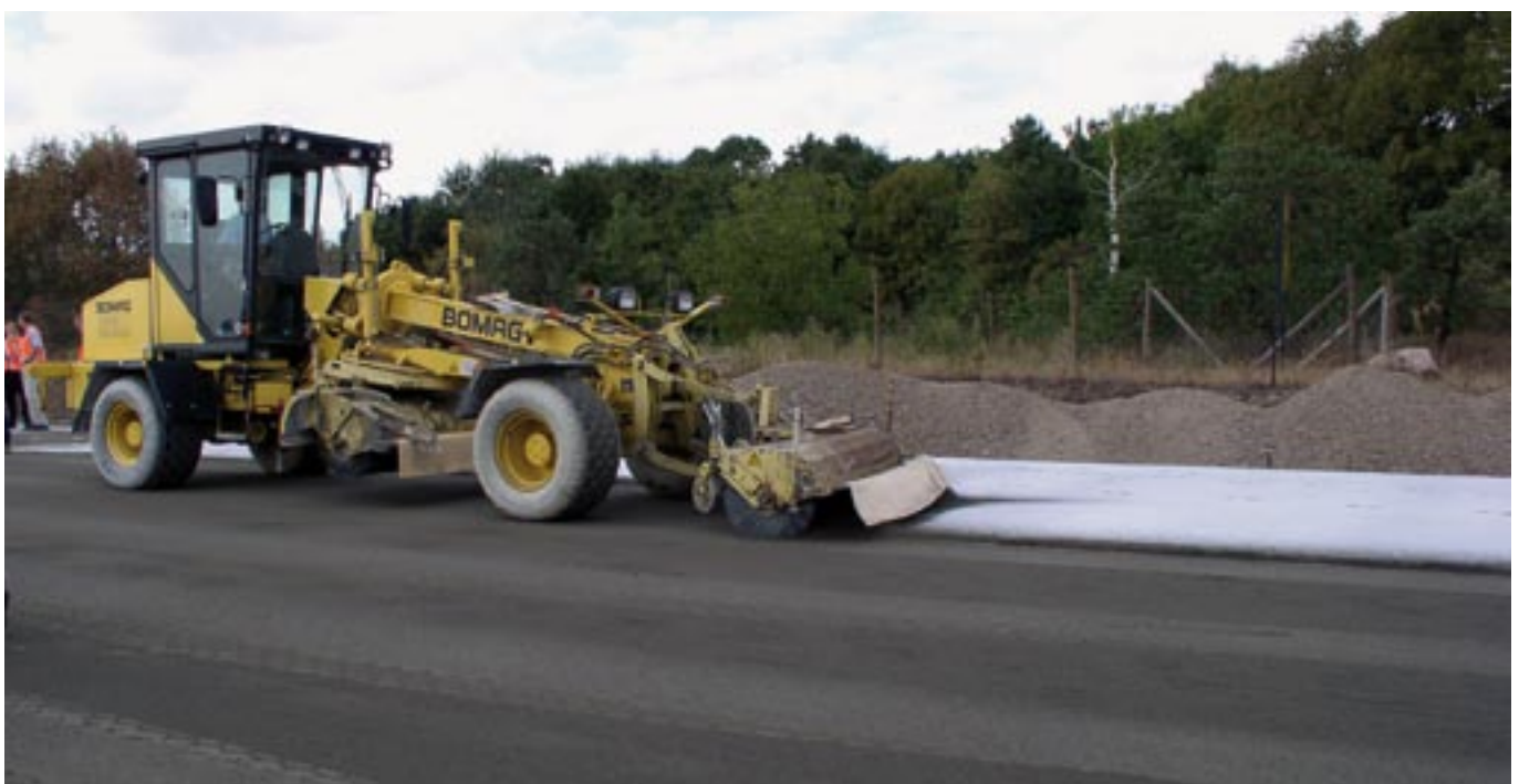
Bild 5: Ausbürsten des Oberflächenmörtels im Nassverfahren
