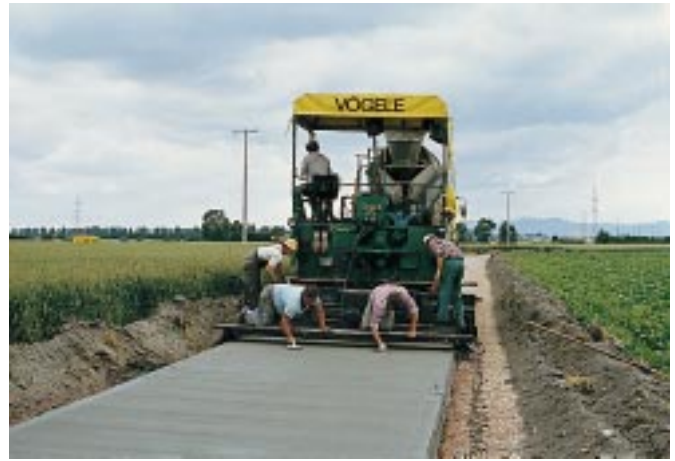
Bild 7: Gleitschalungsfertiger/Transportfahrzeug beim Bau einer Betondecke für einen Wirtschaftsweg
