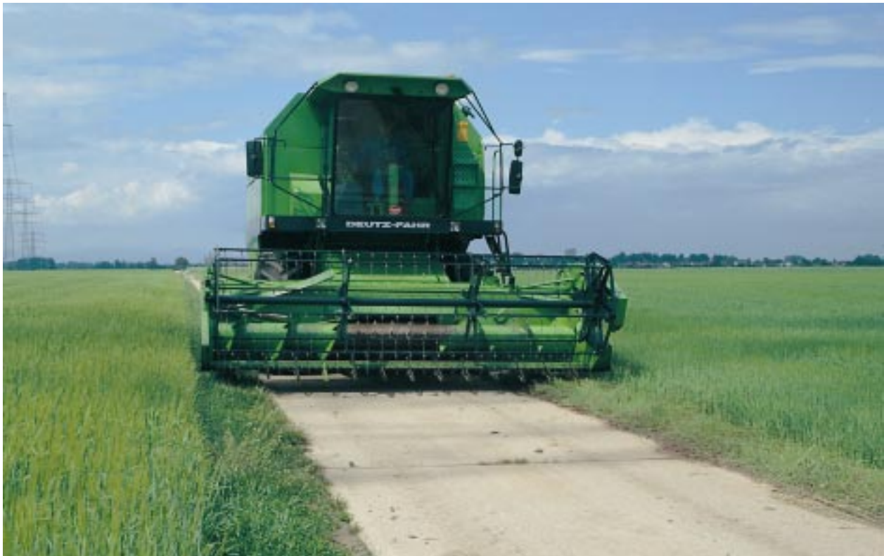
Bild 1: Wirtschaftsweg mit Betondecke
