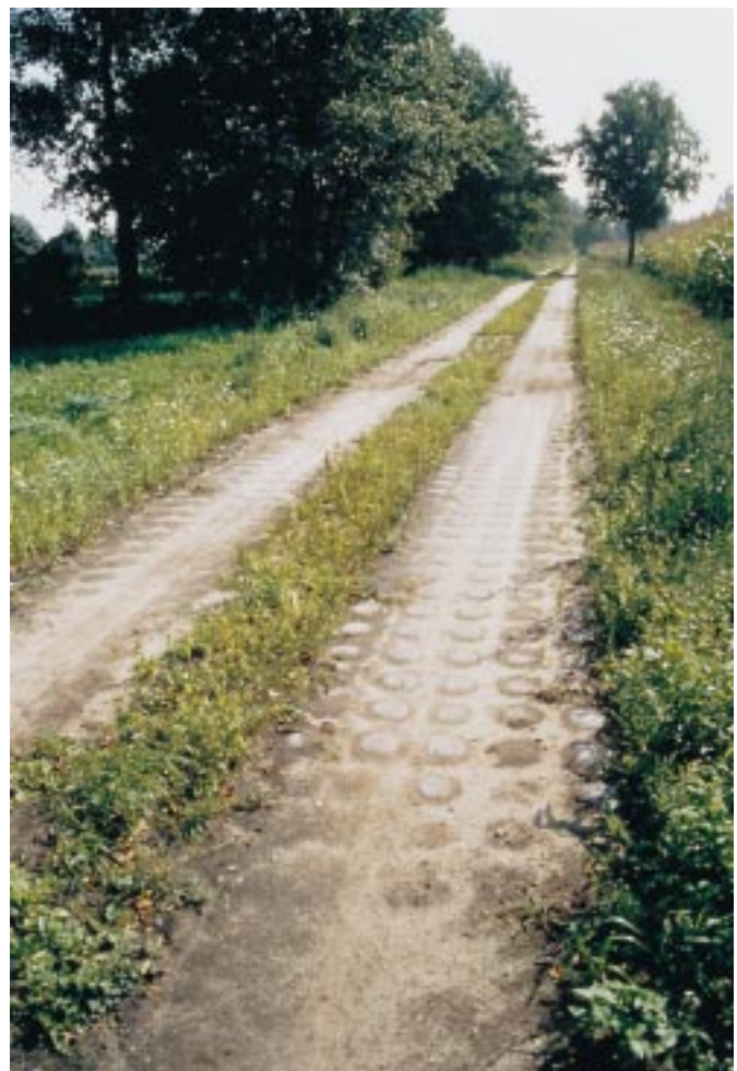
Bild 8: Spurbahn aus Öko-Pflastersteinen mit Geogitterverbund
