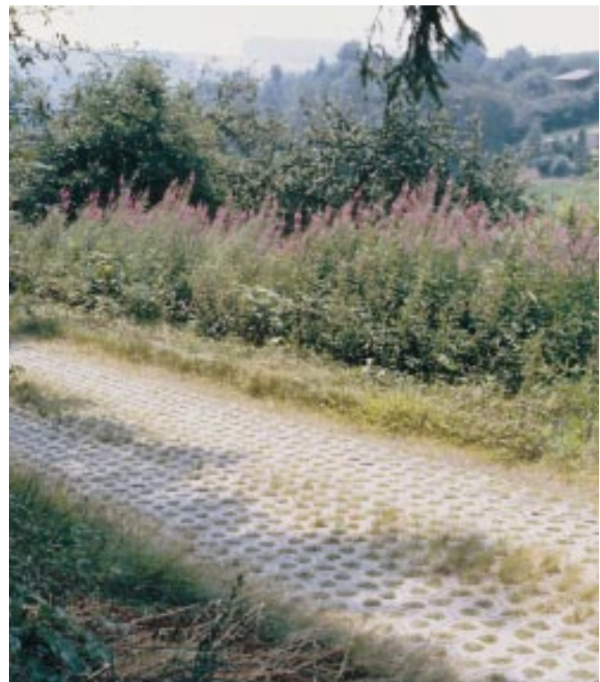
Bild 6: Mit Rasenverbundsteinen befestigter Weg
