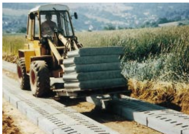
Bild 3: Verlegen von gelochten Spurplatten
