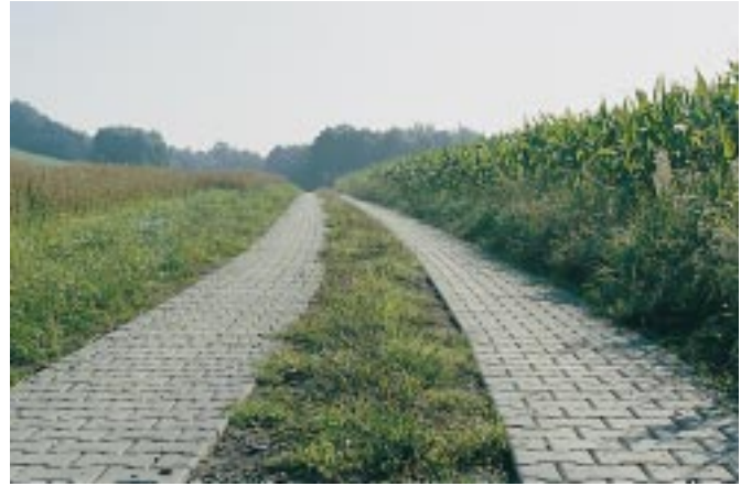
Bild 5: Spurweg aus Verbundsteinpflaster
