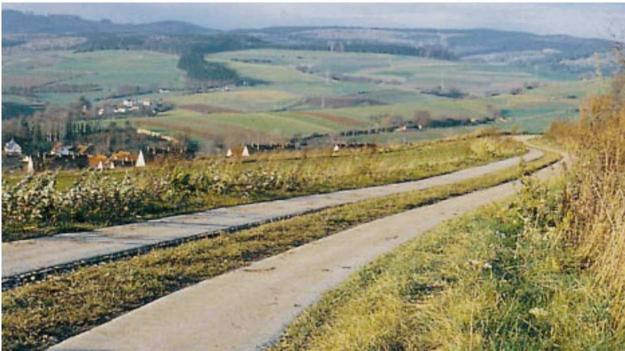
Bild 1: Spurweg aus Orthbeton
