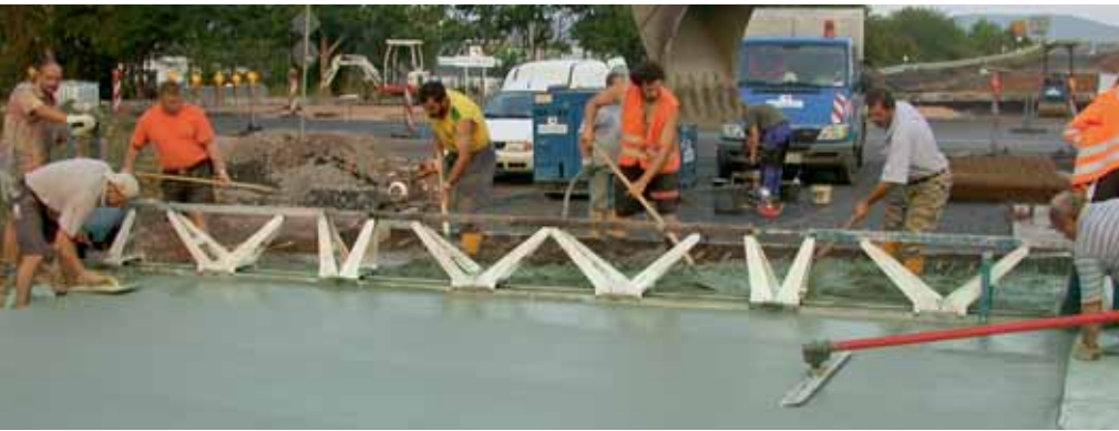
Bild 6: Betoneinbau mit Rüttelbohle und Herstellen der Oberfläche
