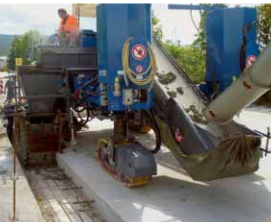
Bild 7: Bewehrung und Verankerung der Bord-/Rinnenanlage (vorn) und Einbau mit einem Gleitschalungsfertiger
