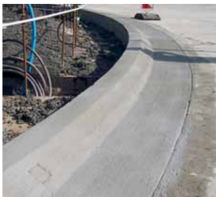
Bild 8: Eingebaute Bord-/Rinnenanlage, noch ohne Fugenschnitt
