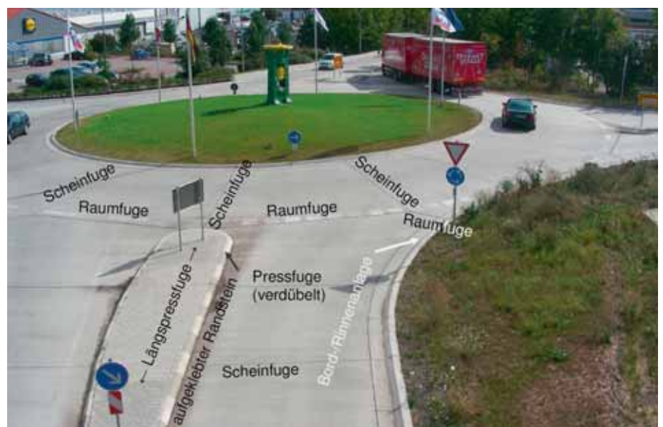
Bild 12: Kreisverkehr im September 2007 mit Anordnung der Fugen
