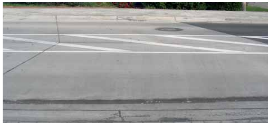
Bild 9: Endfelder der Betonfahrbahn, vergossene Pressfuge im Winkel von 17^\circ und anschließender Asphaltaufbau mit Helligkeitswechsel
