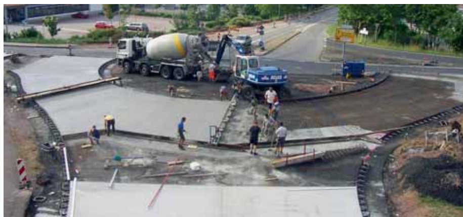
Bild 4: Betoneinbau der Kreisfahrbahn in Bauphase 1
