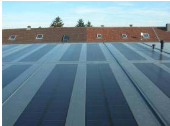
Abb. 16: iRoof-Pilotprojekt BV Oberhausen
