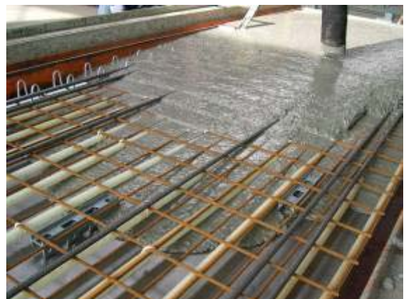
Abb. 9: Betonage einer iRoof-Oberschale mit SVB
