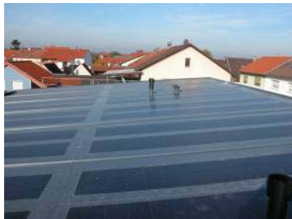
Abb. 1: iRoof-Dachfläche, BV Oberhausen
