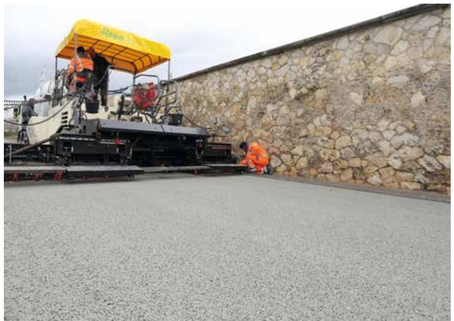
Dränbeton kann eine Flächenversiegelung vermeiden und den Lärm reduzieren.
